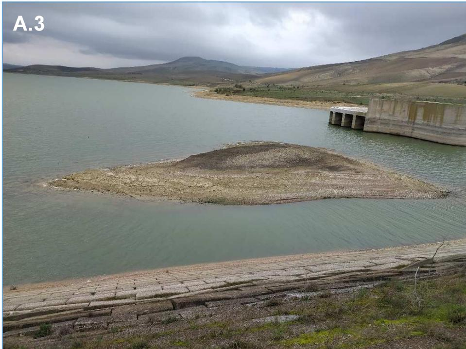
**Figura 65.** Segni evidenti di interrimento si riconoscono nell'invaso di Serra del Corvo proprio dinnanzi alle opere di presa di EIPLI.
