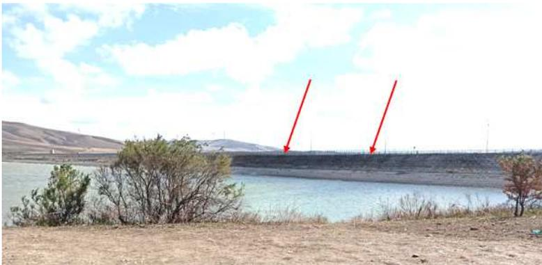
**Figura 30. Paramento di monte della diga. Le frecce indicano la presenza di vegetazione tra le piastrelle del paramento di monte.**
