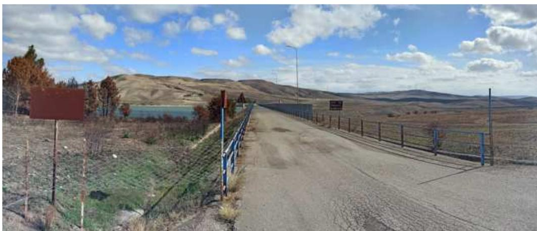
**Figura 32. Stato di abbandono di recinzioni, cartellonistica, vegetazione e strada visibilmente ammalorata.**
