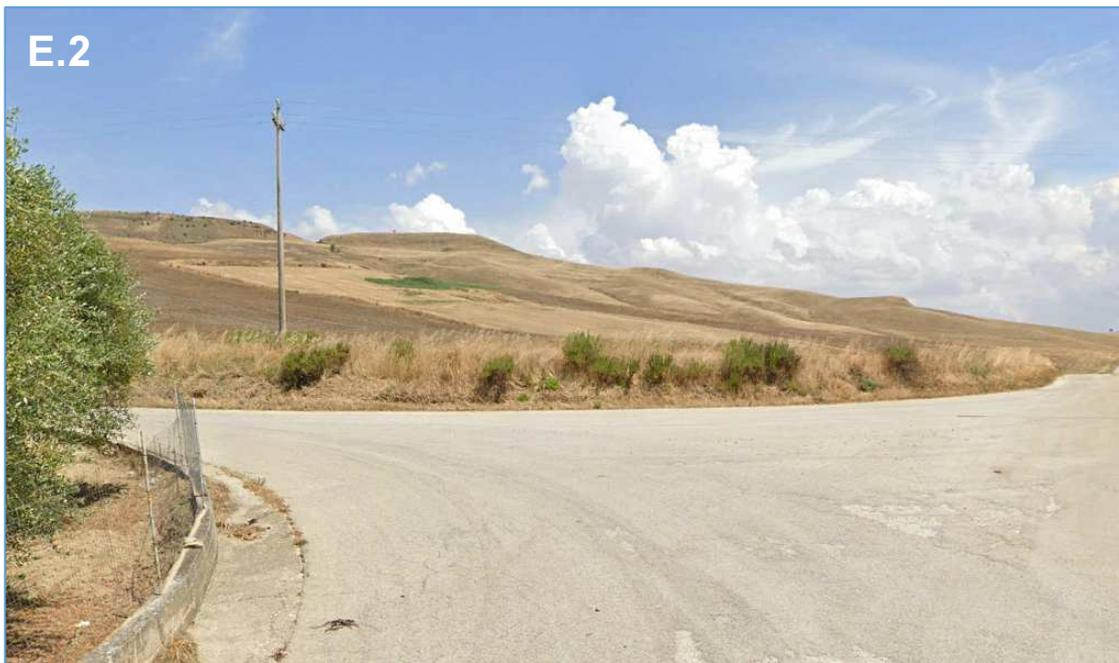
**Figura 79.** Lo svincolo tra la strada poderale di Contrada Basentello e la SP26 lungo cui correrà il cavidotto interrato. In sinistra della SP26 verrà realizzata l'area di transizione tra il cavidotto interrato e l'elettrodotto aereo.
