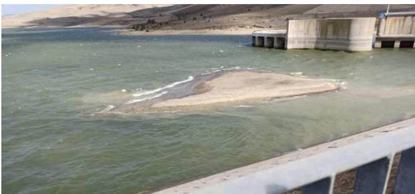
**Figura 31. Sedimenti accumulati in corrispondenza del paramento di monte.**
