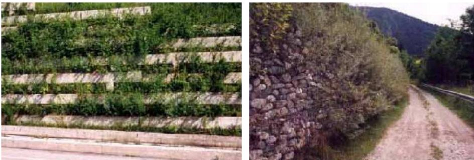
**Figura 59. Esempi di muri cellulari e gabbionate rinverdite.**
