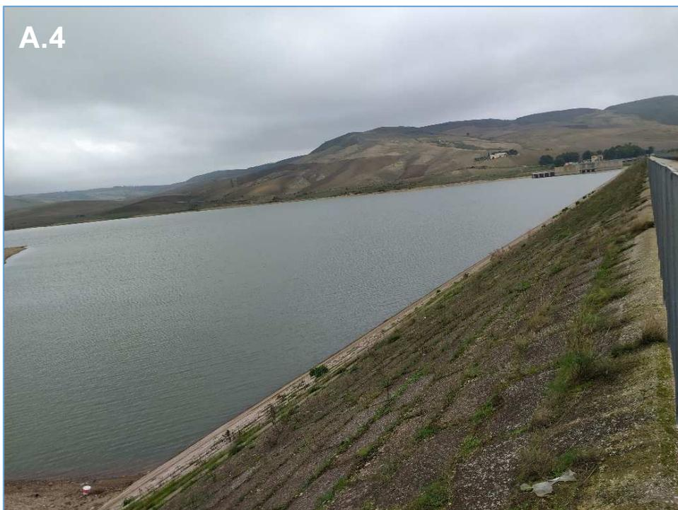
**Figura 66.** Il paramento di monte della diga del Basentello a servizio dell'invaso irriguo di Serra del Corvo.
