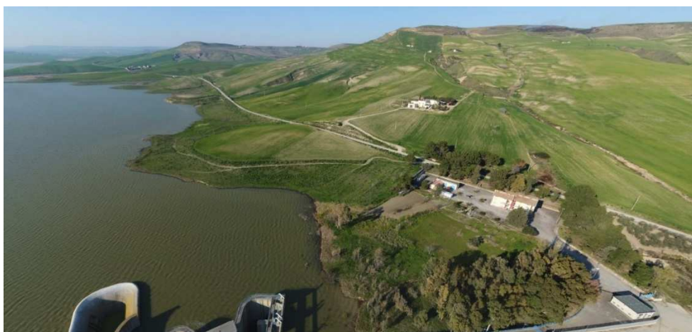
Figura 54. Vista aerea dei siti in cui verrà realizzata la centrale interrata e verranno posate le condotte forzate.
