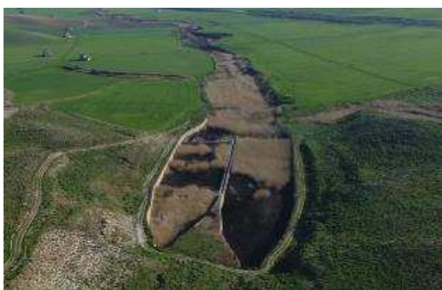
Figura 11. Gli ambienti umidi che si sono creati a valle degli organi di scarico della diga di Serra del Corvo, dai quali viene rilasciato anche il DMV di legge.
