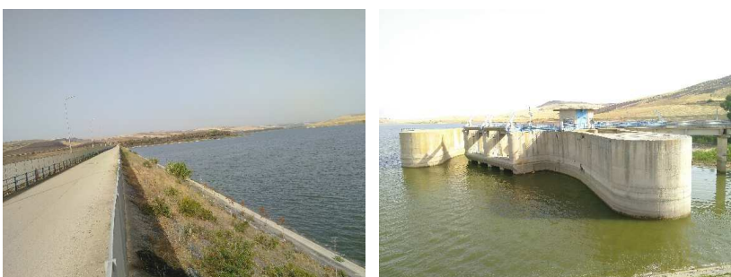
Figura 18. Il paramento di monte dello sbarramento della diga e organi di presa e sfioro presso l'invaso di Serra del Corvo.
