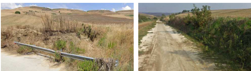
Figura 14. Il fossato non regimato che degrada dai versanti in erosione nei pressi della diga di Serra del Corvo (a, a sinistra) e piccolo canale di drenaggio lungo la strada di accesso al sito dove verrà realizzato l'invaso di monte (b, a destra).
