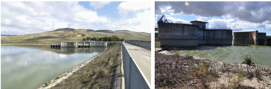
Figura 3. Alcune immagini delle strutture esistenti per i prelievi irrigui gestite da EIPLI.
