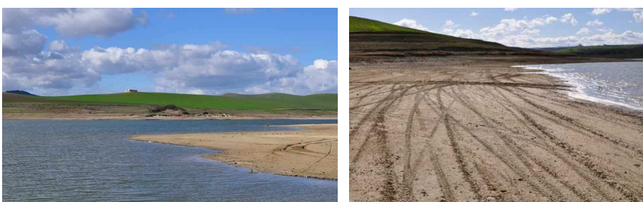
Figura 17. Gli estesi depositi di materiale solido all'interno del lago hanno causato una netta riduzione del volume utile di invaso.
