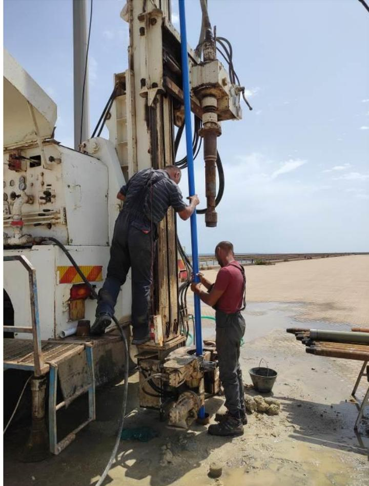
Riempimento del intercapedine tubo-foro di sondaggio con materiale drenante
