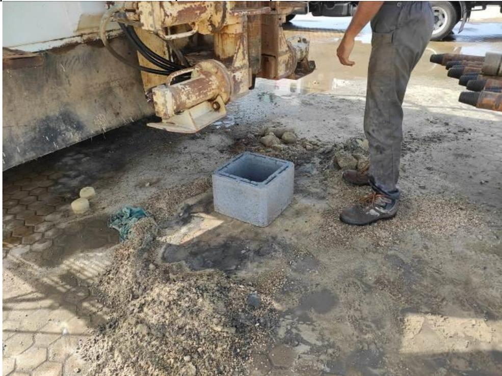
Ripristino foro di sondaggio attrezzato a piezometro, con pozzetto carrabile
