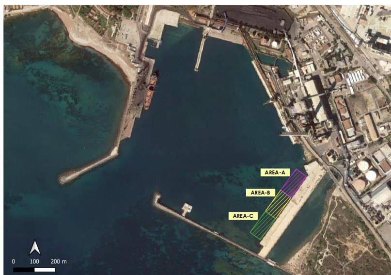
Figura 6-1 - Banchina EST - Aree di riferimento per il calcolo dell'altezza d'onda significativa media (H_s)_Q .
