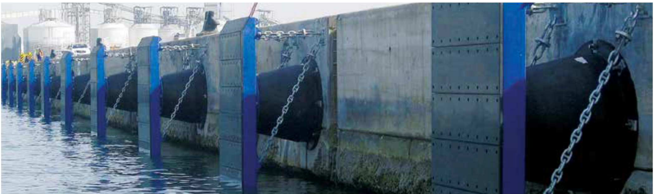
Figura 10-5 – Esempio di respingente modello Super Cone
