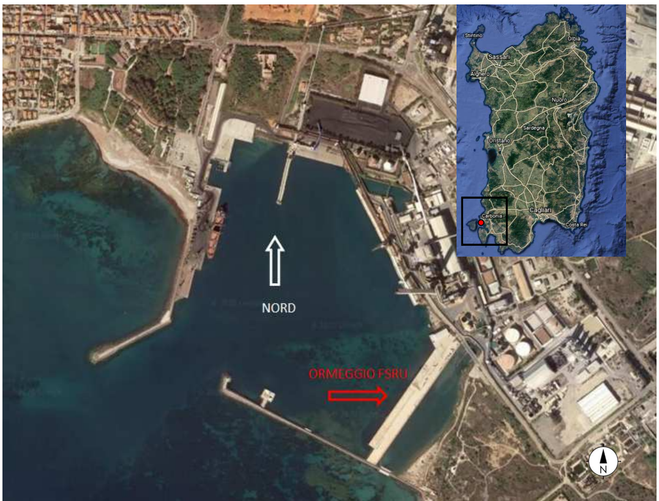
Figura 6-1 – Inquadramento geografico dell'area di intervento
