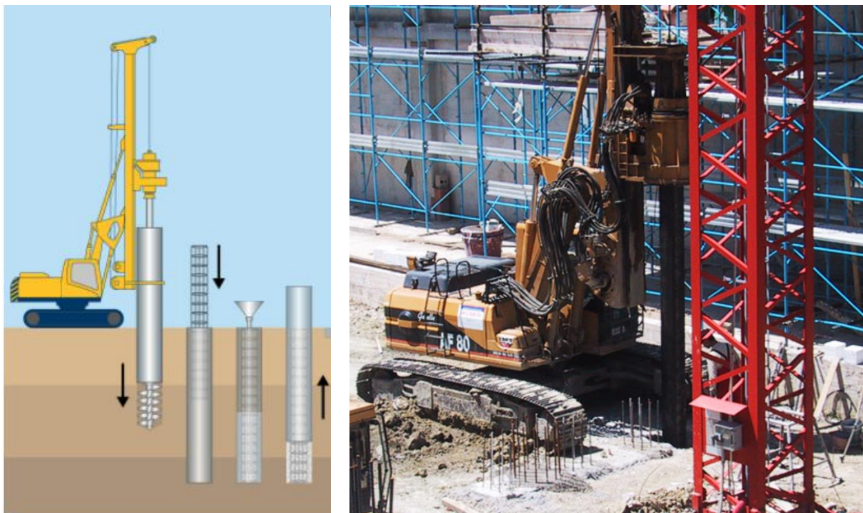
Figura 4-5: Realizzazione di pali trivellati: (a) schema esecutivo; (b) foto macchina
