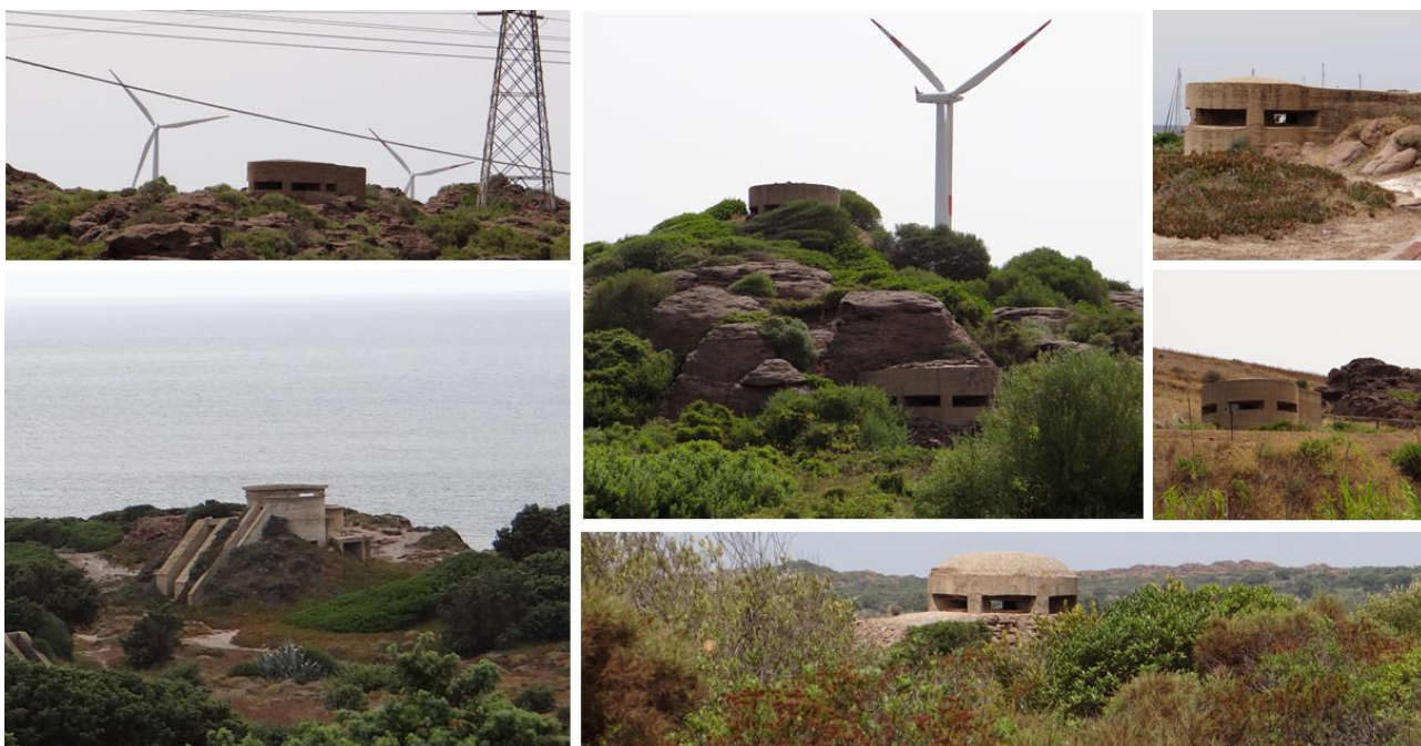
Figura 6-59: Casematte tra Capo Altano e Portovesme
