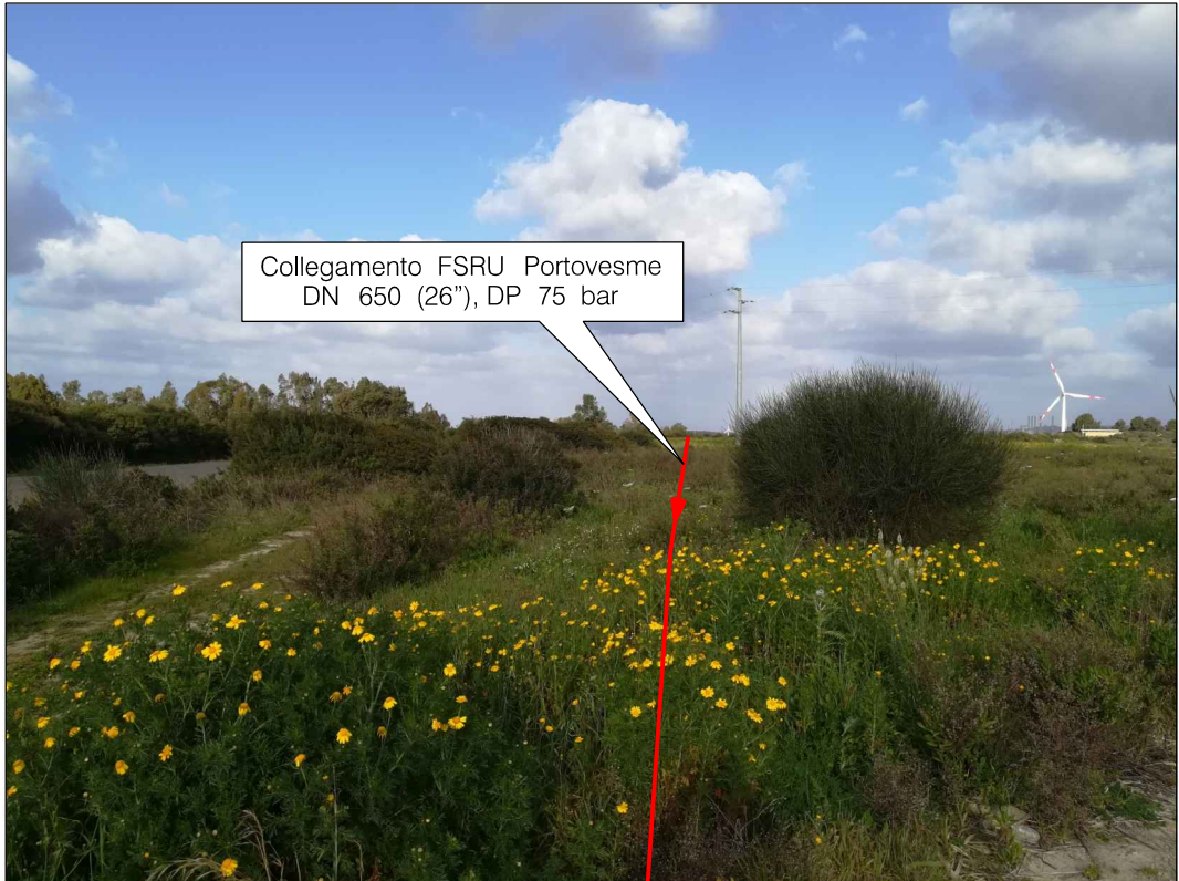
Percorrenza della condotta in zona agricola parallelamente alla strada provinciale S.P. n. 2
