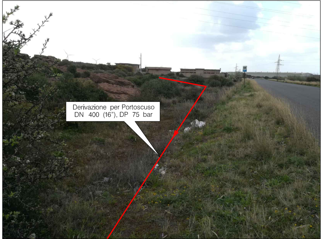
Vista del metanodotto Der. per Portoscuso DN 400 (16") in parallelismo con la strada provinciale S.P. n.2
