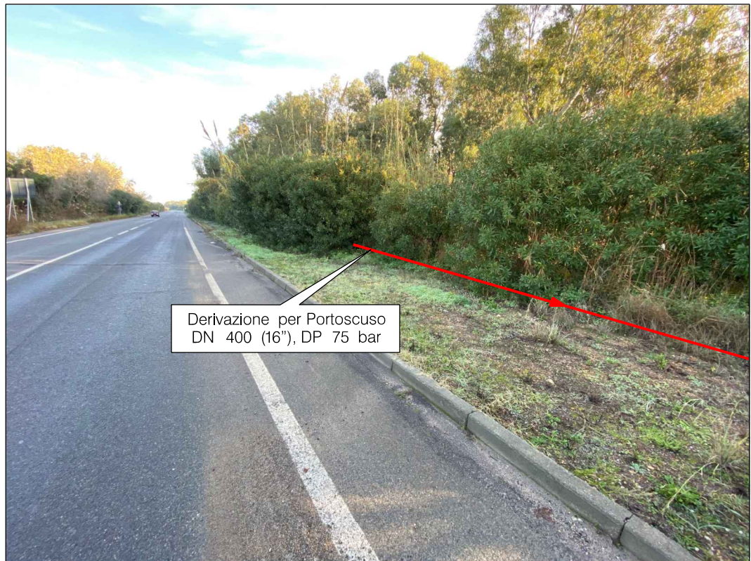
Percorrenza della condotta tra Rio de su Cannoni e la strada provinciale S.P. n.2
