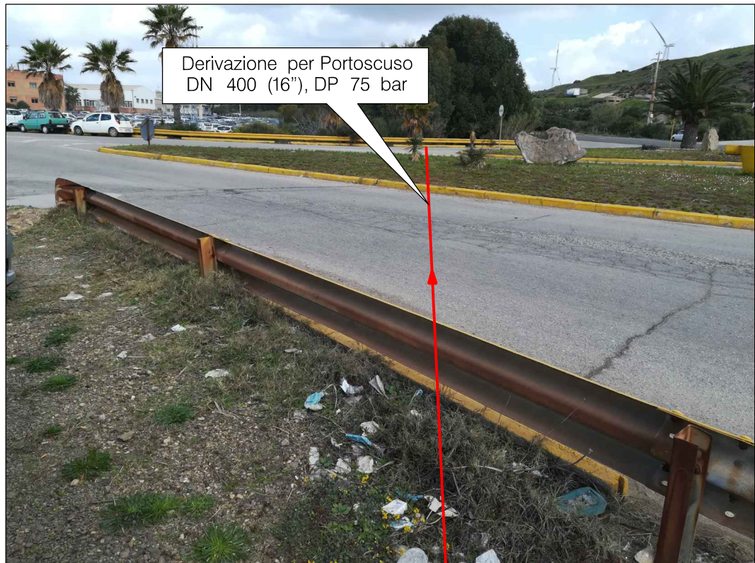
Attraversamento dello svincolo della strada provinciale S.P. n.2, nel comune di Portoscuso
