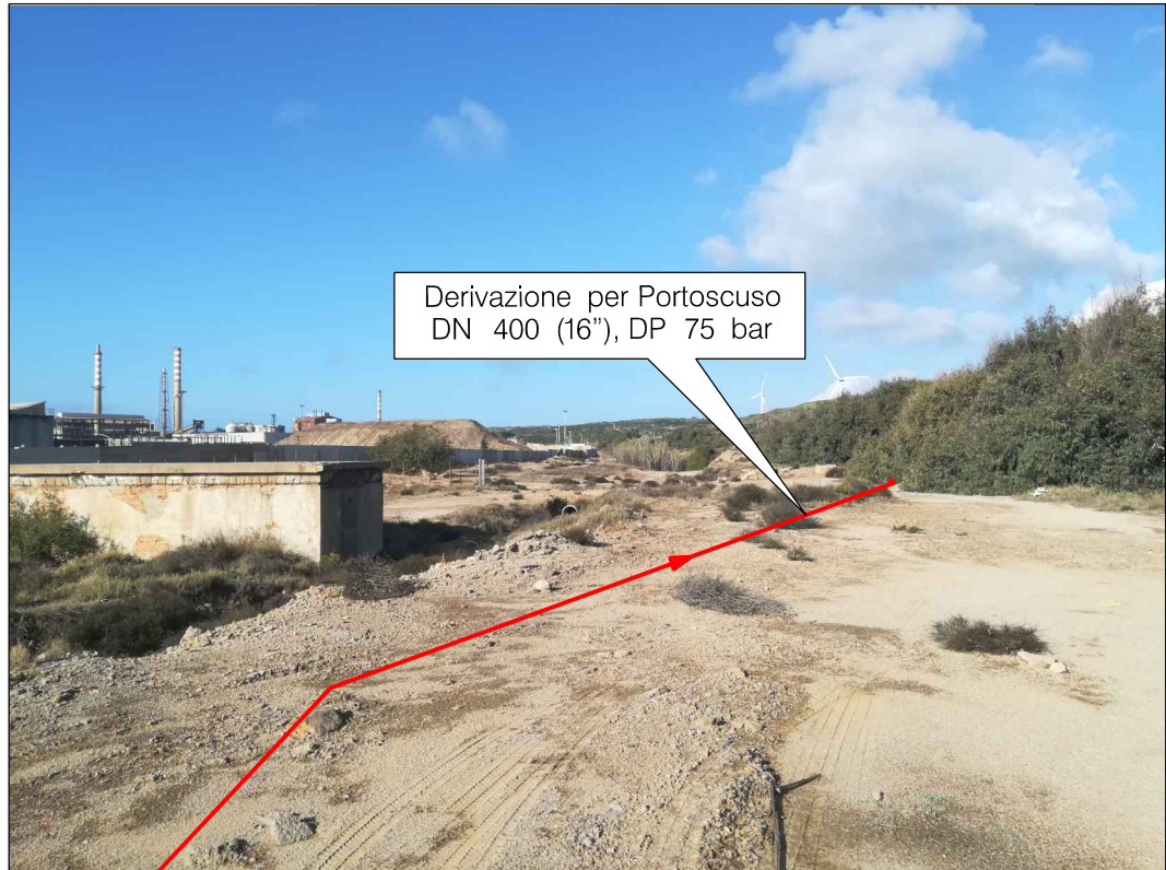
Vista del metanodotto Der. per Portoscuso DN 400 (16'') nelle vicinanze del Polo Industriale di Portovesme
