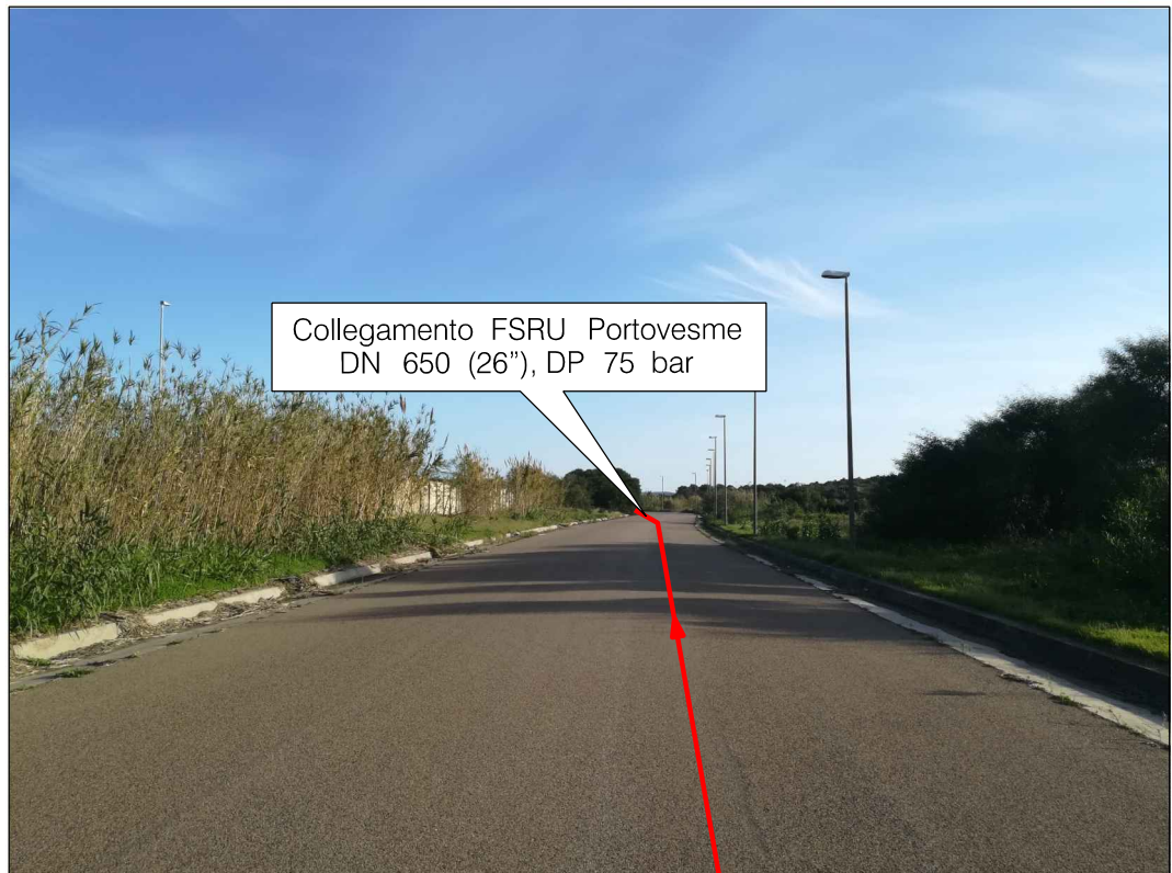
Percorrenza della condotta "Coll. FSRU Portovesme DN 650 (26")" su strada "Asse interno industriale Portovesme"
