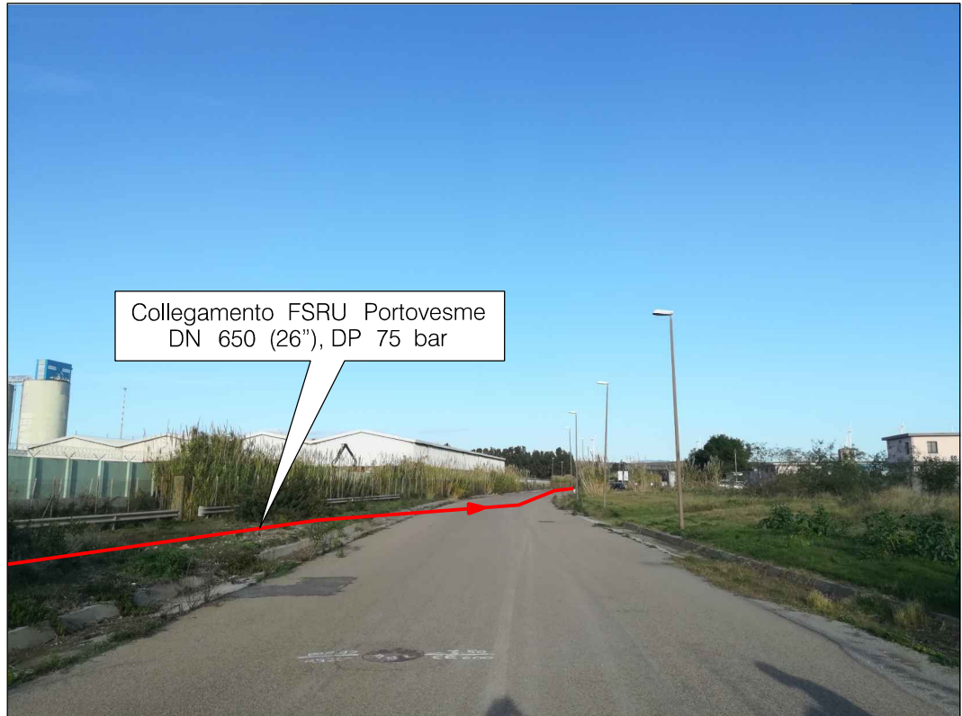
Percorrenza della condotta "Coll. FSRU Portovesme DN 650 (26")" su strada "Asse interno industriale Portovesme" e relativa banchina laterale
