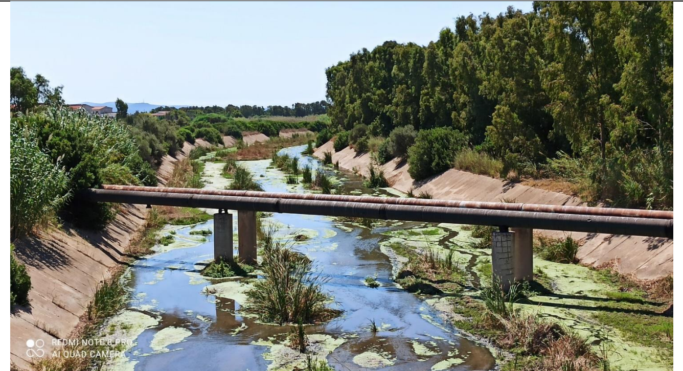
Foto 2 – Vista del punto di attraversamento dal ponte sulla strada Via Sulcis
