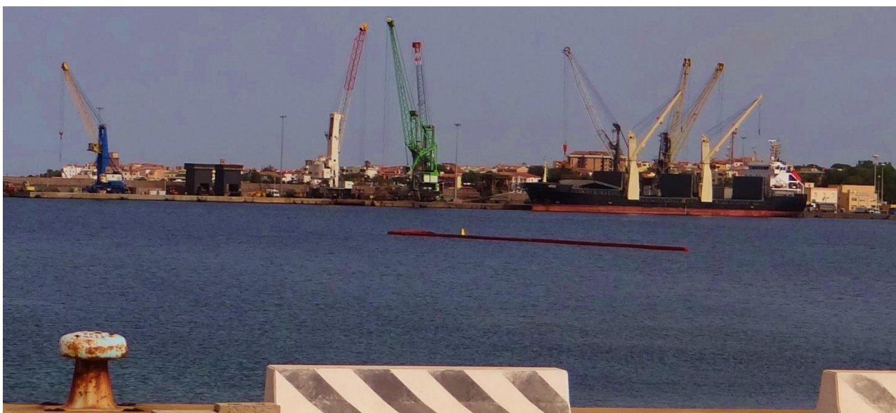
Figura 2-20: Nave Ormeggiata lungo la Banchina Commerciale di Portovesme
