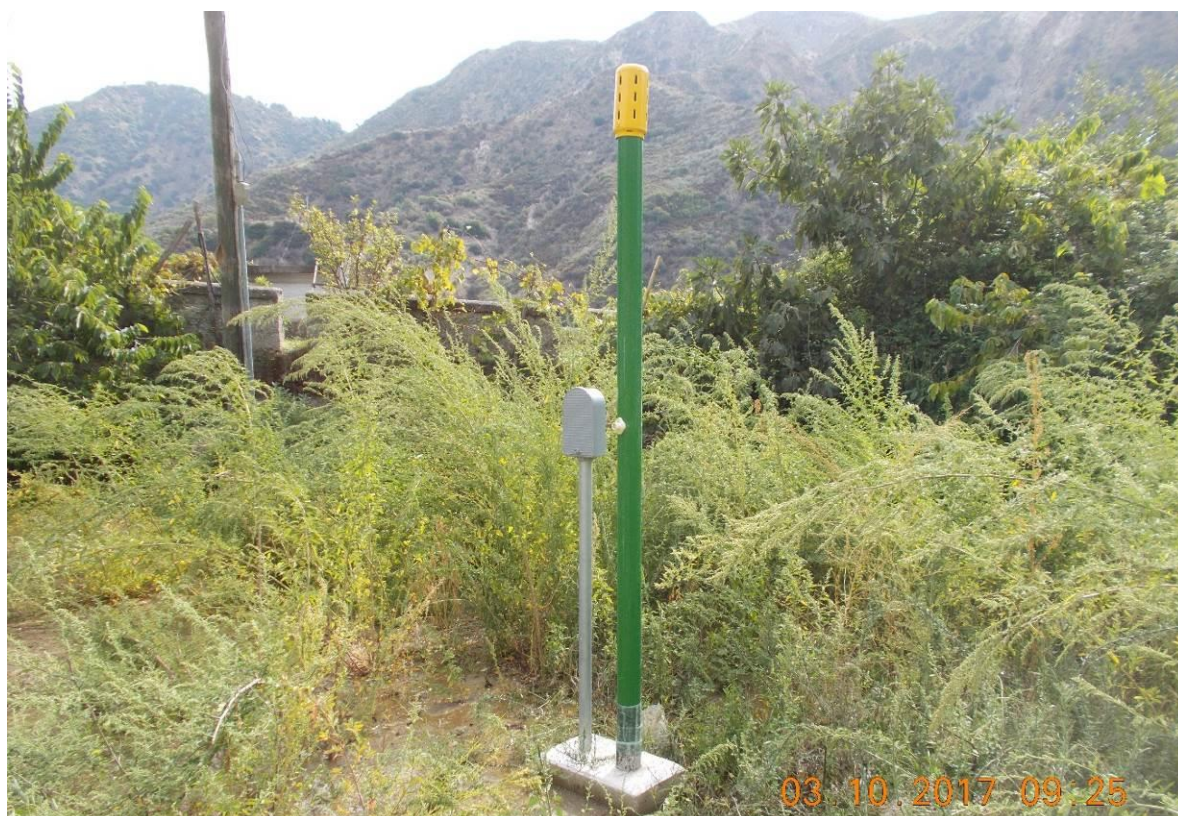
Figura 6-11: Esempio di opera di sfiato
