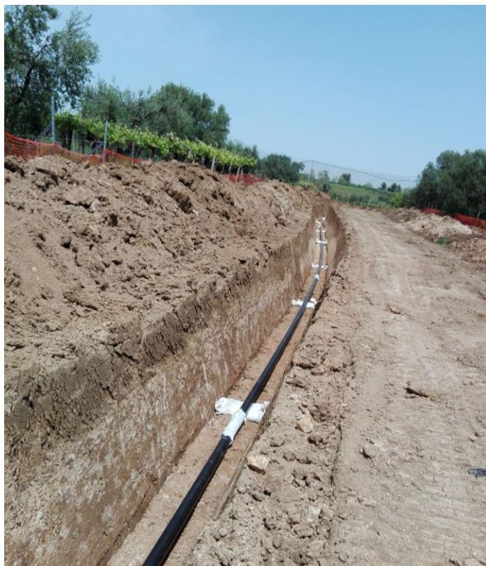
Figura 6-7: Esempio di posa della condotta
