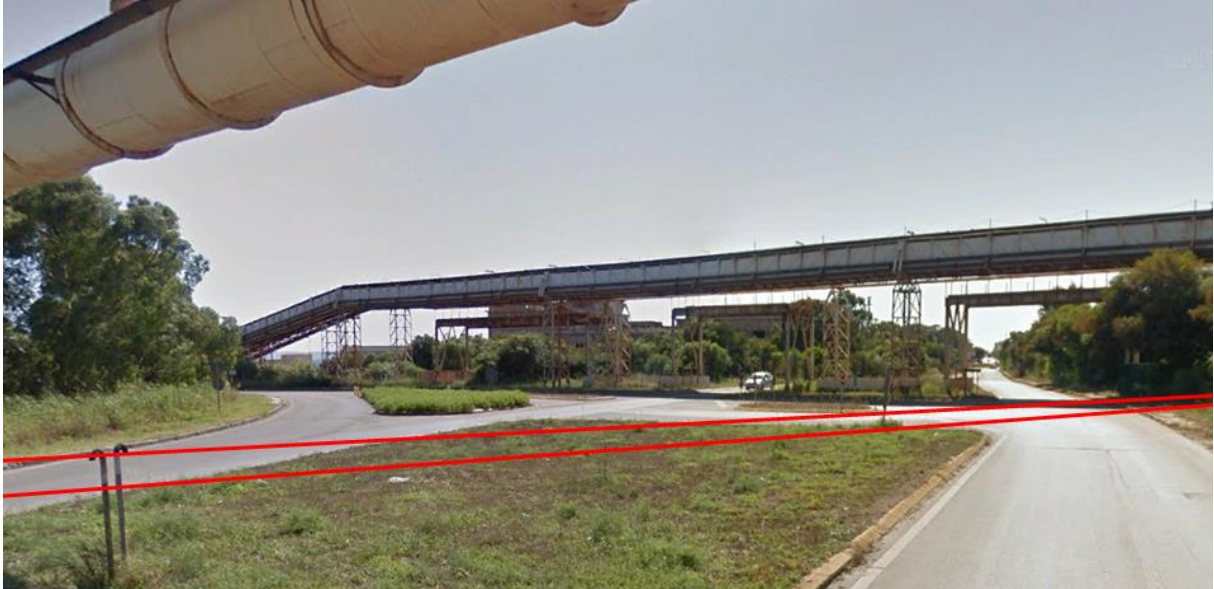
Figura 3-28 Vista in direzione ovest dell'area in cui è previsto il passaggio del gasdotto interrato "Allacciamento Eurallumina DN 300 (12") DP 75 bar" e del tratto terminale della "Derivazione per Portoscuso DN 400 (16") DP 75 bar".
