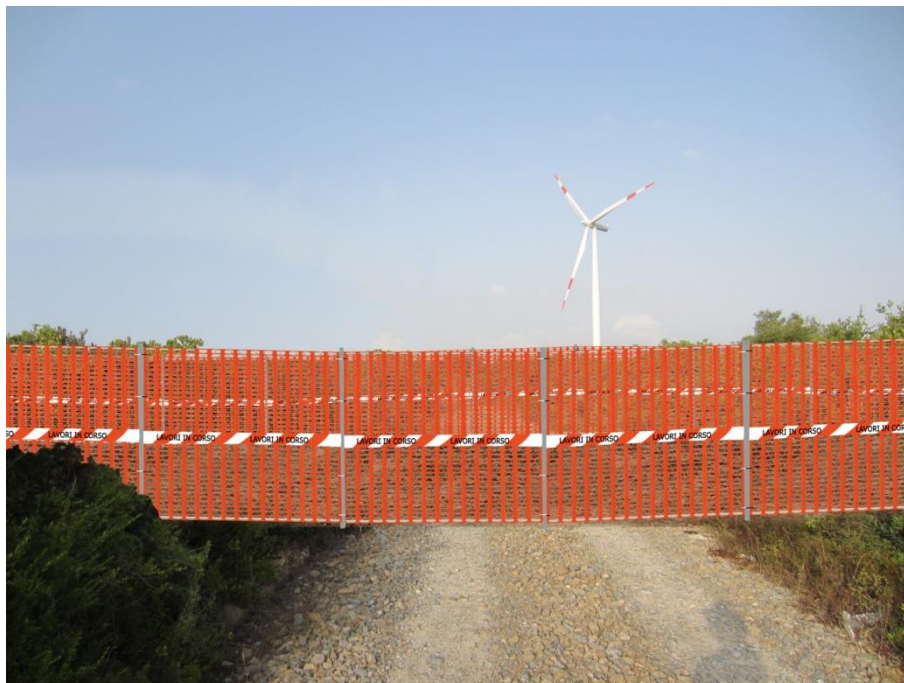
Figura 3-45 Punto di vista n.4: fotosimulazione del cantiere.
