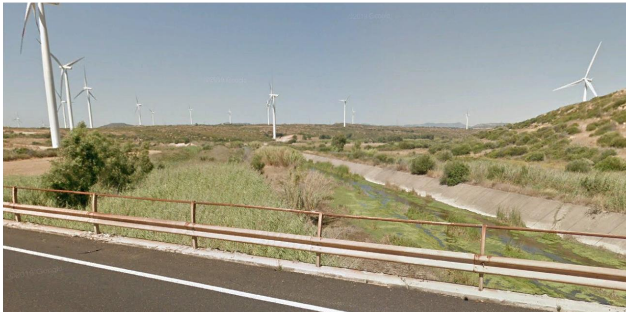
Figura 3-9 Vista, in direzione nord, del Canale di Paringianu (tratto terminale del Rio Flumentepido) e del parco eolico presente nell'entroterra sul versante meridionale dalla S.P.2
