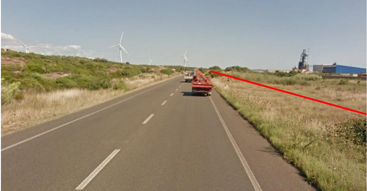
Figura 3-7 Vista in direzione sud-ovest dalla S.P. n.2
