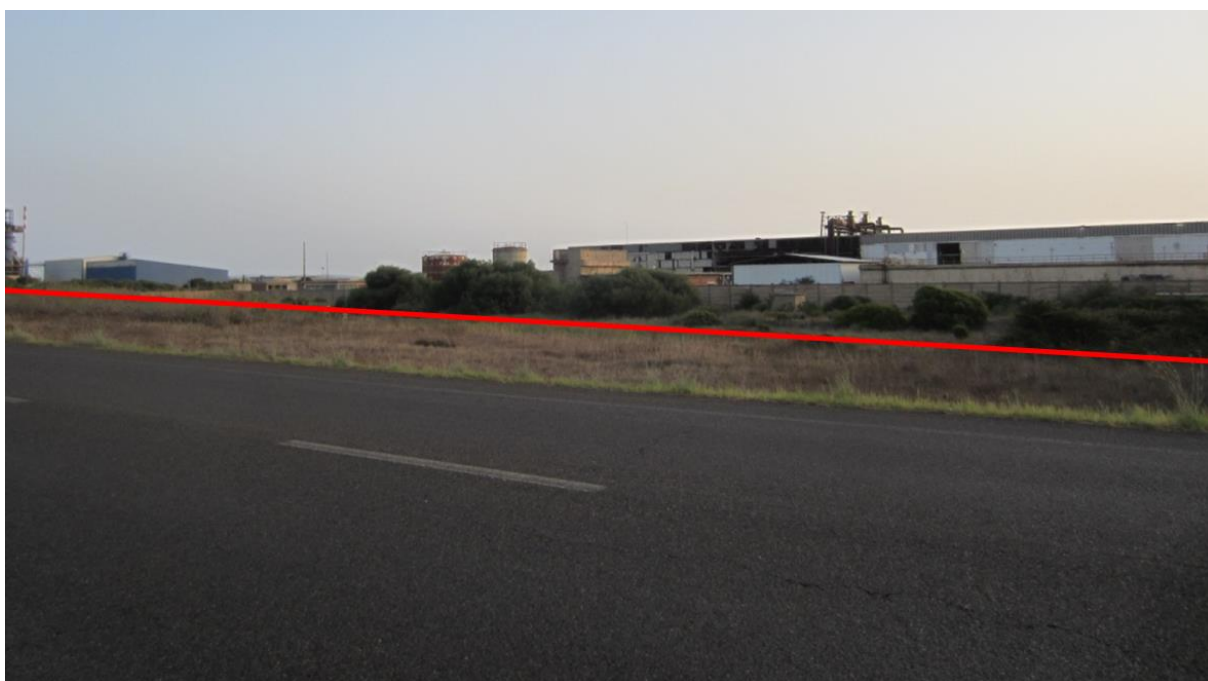
Figura 3-6 Vista dalla S.P.2 in direzione sud (versante meridionale della S.P.2, km 2.085 tracciato Collegamento FSRU Portovesme DN 650 (26'') - DP 75 bar)
