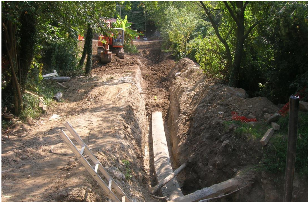
Figura 6-8: Esempio di rinterro della condotta (1)
