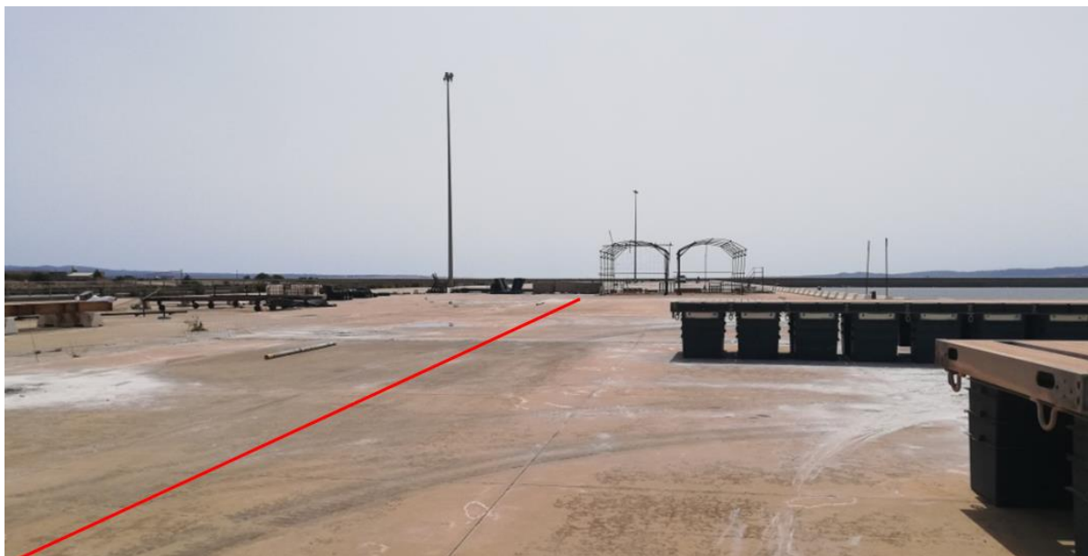
Figura 3-1 Vista fotografica della banchina in Località Porto de sa Linna , dove il progetto prevede il posizionamento del P.I.L. n.1 (km 0 tracciato Collegamento FSRU Portovesme DN 650 (26'') - DP 75 bar)
