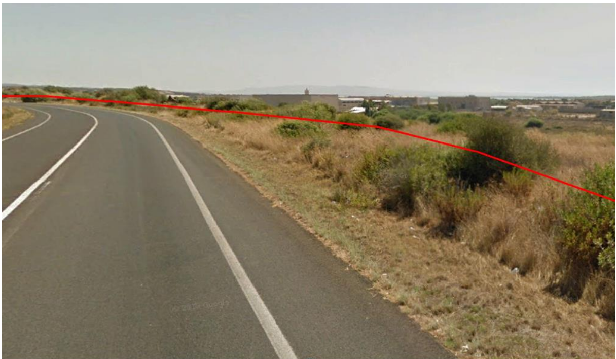
Figura 3-8 Vista in direzione sud del versante meridionale della S.P. n.2 (Località Concali Arrubbiu, km 3,00)
