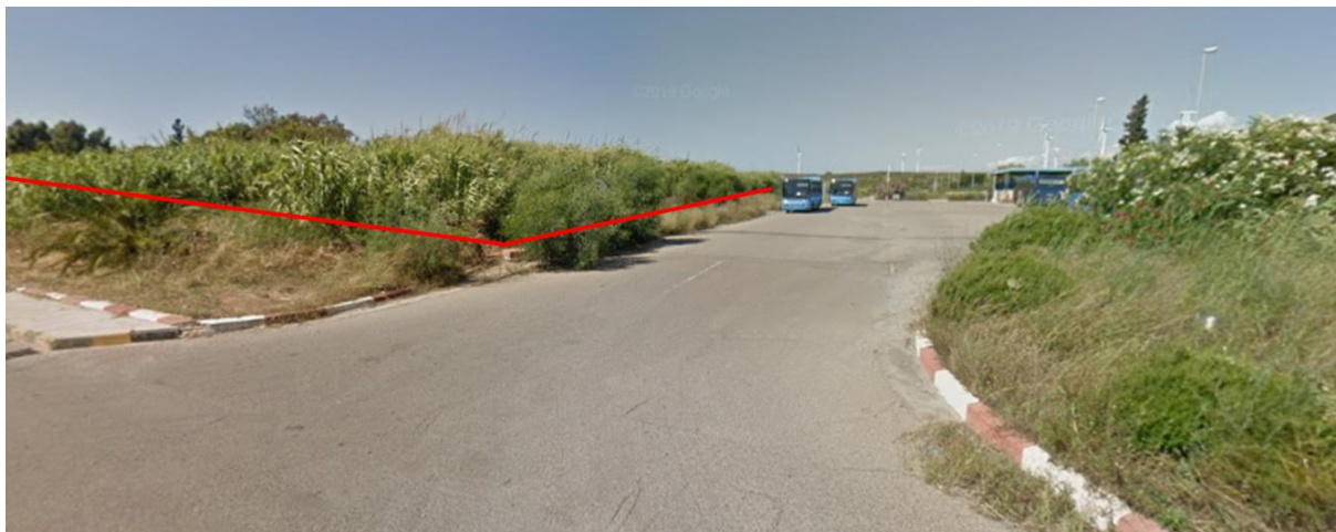
Figura 3-5 Vista dalla SP 75bis in direzione nord-est verso la strada locale che unisce le S.P. 75 bis e la S.P. n.2
