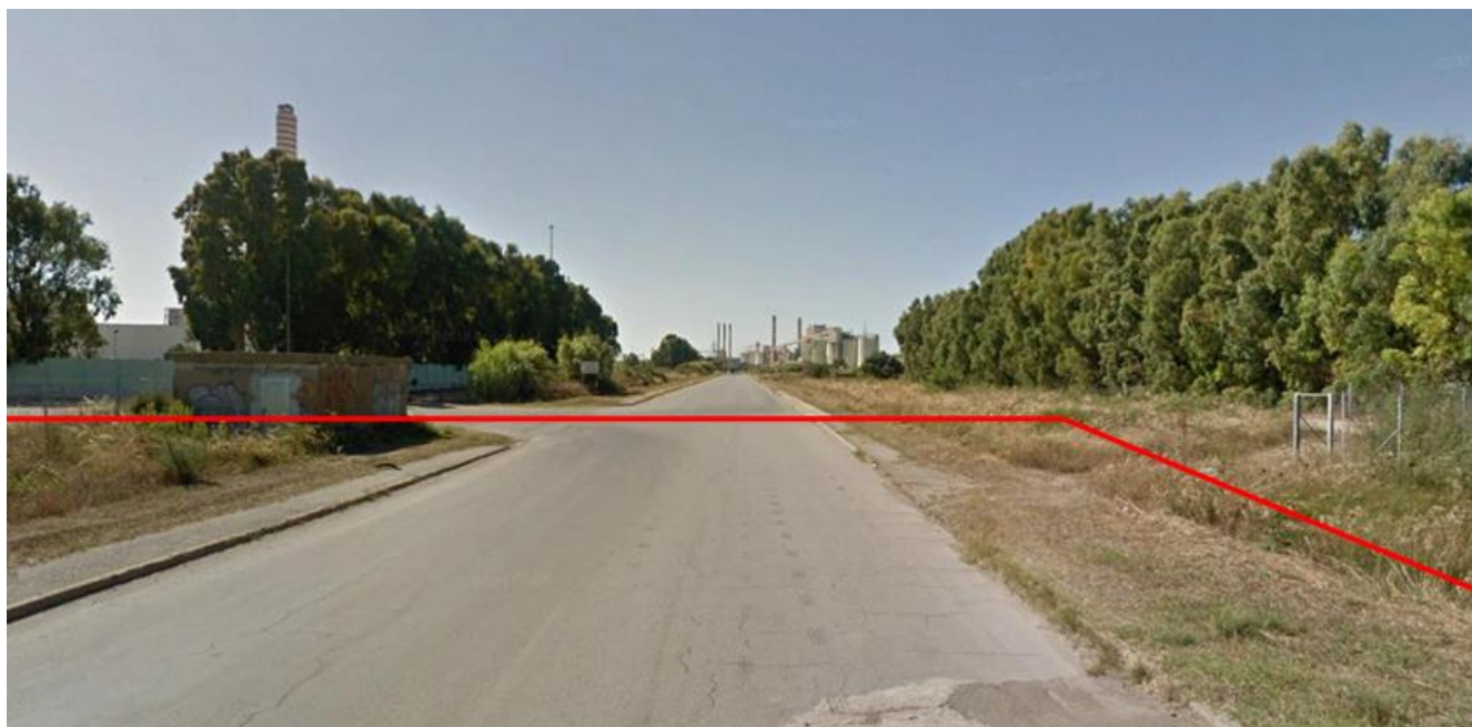
Figura 3-2 Vista dalla S.P: 75bis in direzione nord-ovest
