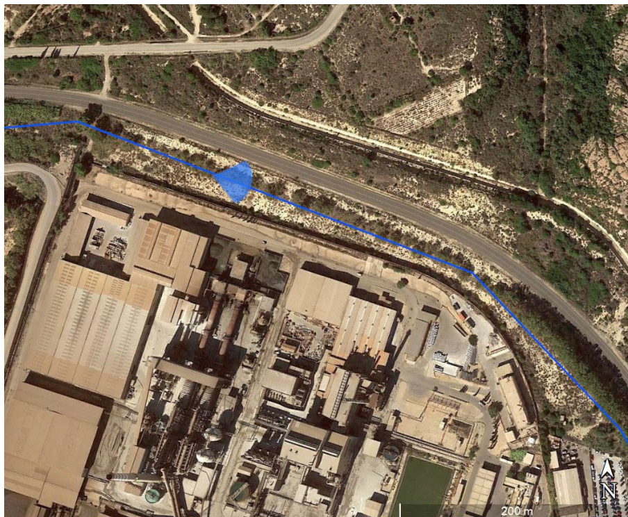
Figura 3-53 Punto di vista n°6 (attraversamenti dell'Asse interno industriale Portovesme e del Rio de Su Cannoni).
