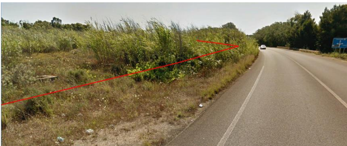
Figura 3-19 Vista in direzione ovest dell'area prossima all'attraversamento del tracciato sul Rio de Su Cannoni (km 3,410)
