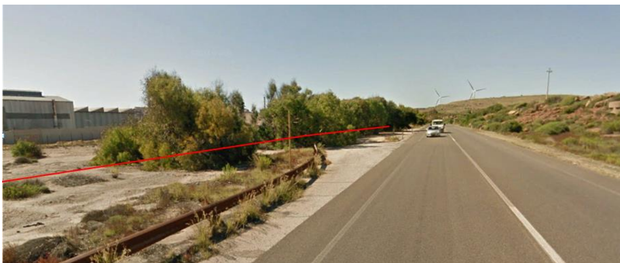
Figura 3-18 Vista del paesaggio in direzione nord in corrispondenza del km 2 del tracciato
