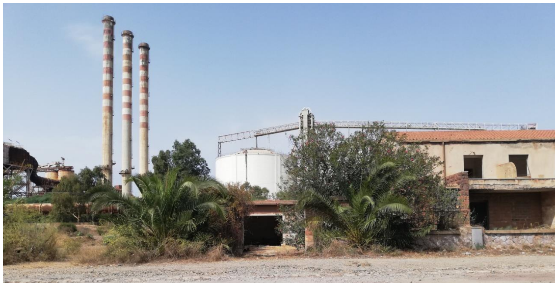
Figura 3-26 Edifici nei pressi dell'area dove sarà edificato l'impianto HPRS
