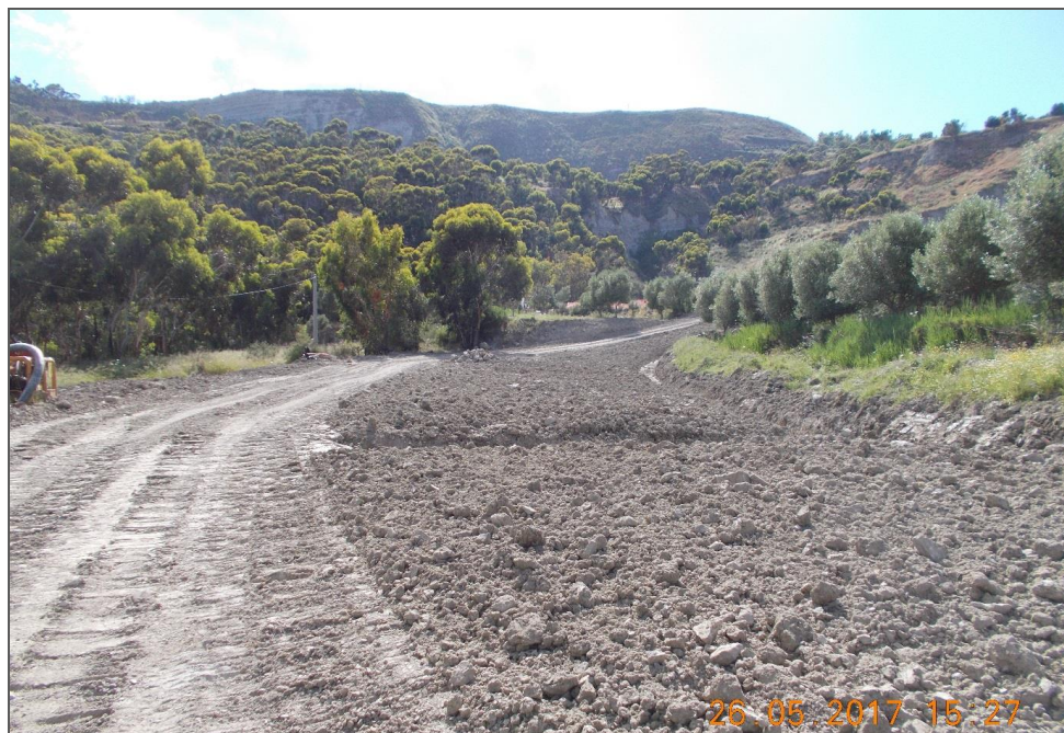
Figura 6-9: Esempio di rinterro della condotta (2)
