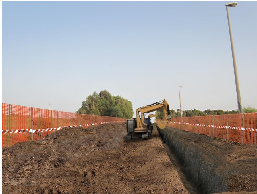
Figura 3-41 Punto di vista n.3: fotosimulazione 3. Vista del cantiere in fase di posa delle tubazioni.
