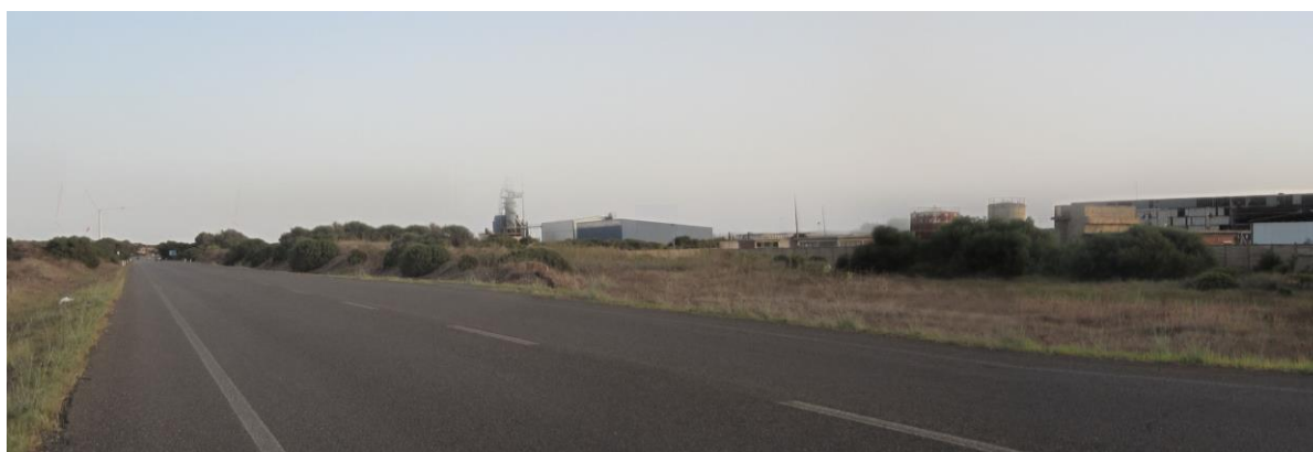
Figura 3-34 Punto di vista n.2: situazione ante operam
