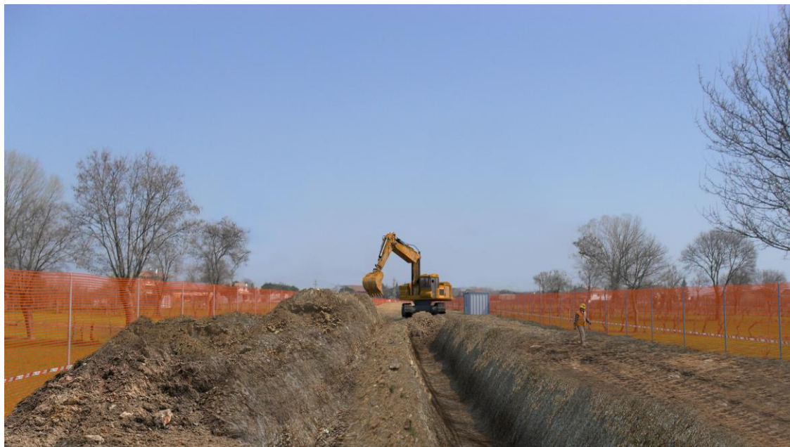
Figura 6-5: Esempio di scavo in trincea
