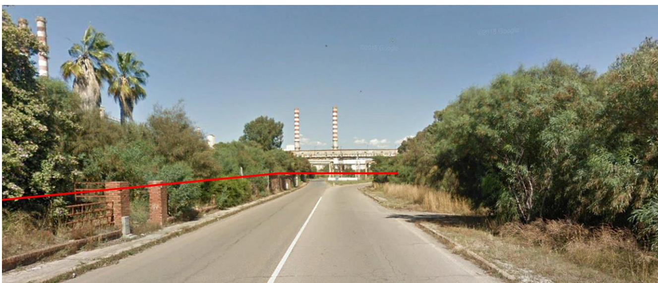
Figura 3-23 Vista dalla S.P. di Portoscuso (via 1° Maggio), in direzione est, lungo il tracciato.
