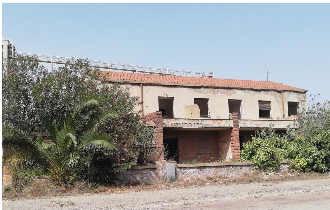
Figura 3-25 Edifici nei pressi dell'area dove sarà edificato l'impianto HPRS
