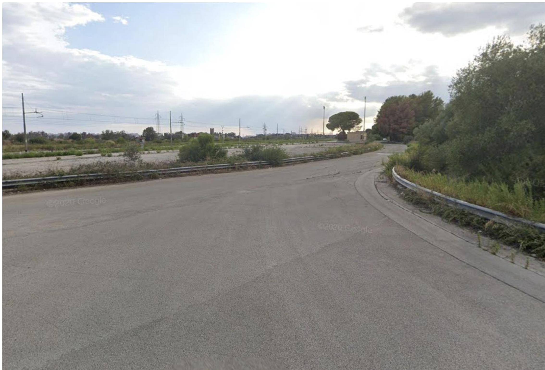
PV2: Vista da Via del Trattarello Tarantino a ridosso della stazione Nasisi
