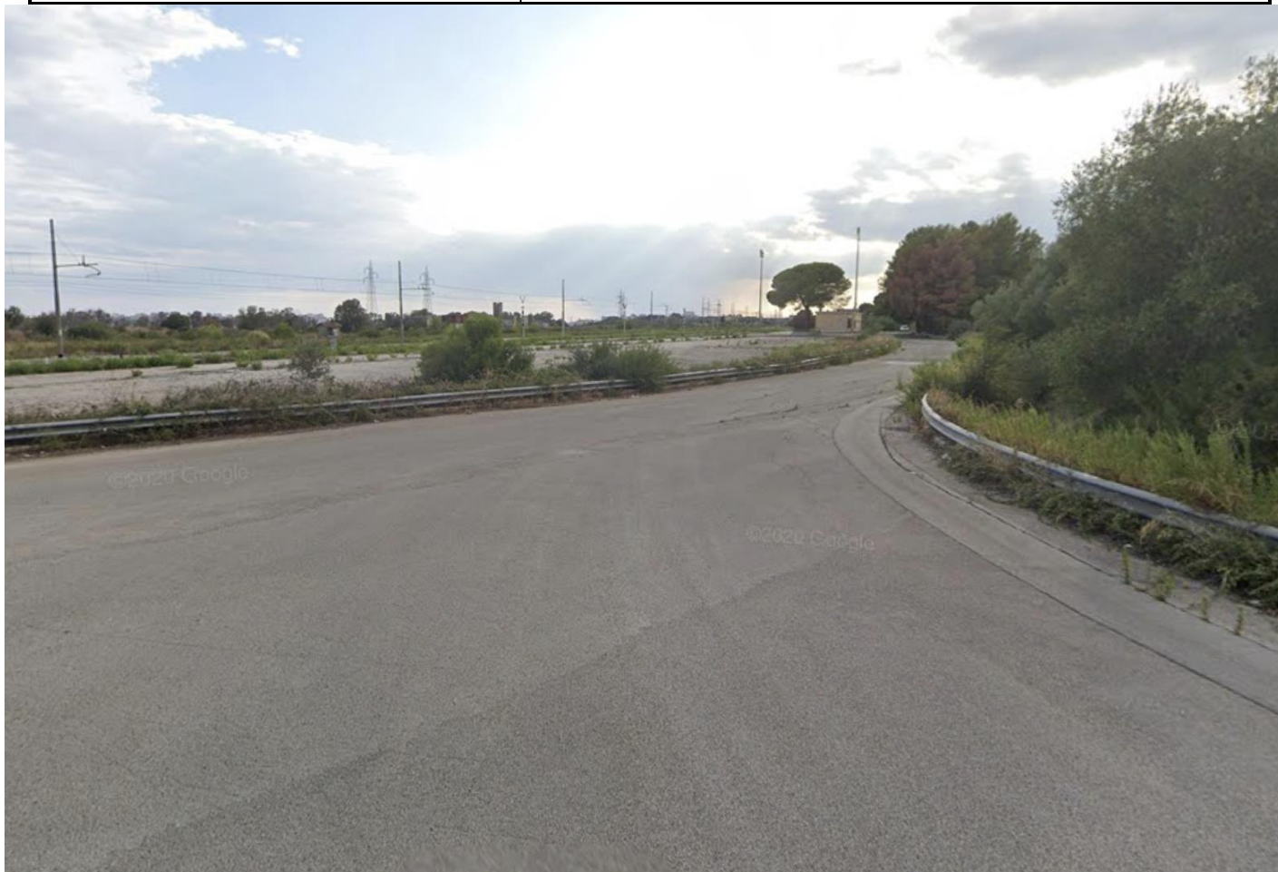
PV2: Vista da Via del Tratturello Tarantino a ridosso della stazione Nasisi
