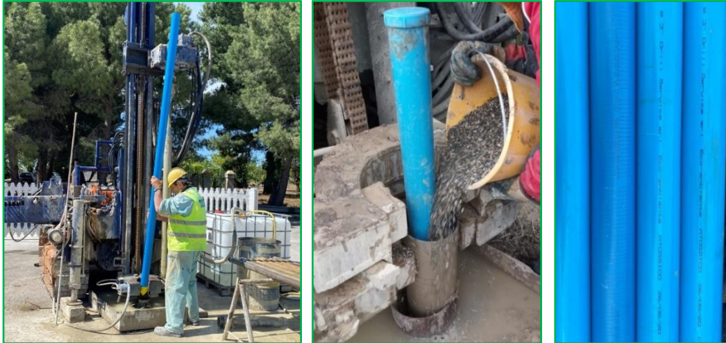
Figura 7: Fase di installazione del piezometro; a destra, particolare dei tubi utilizzati.
