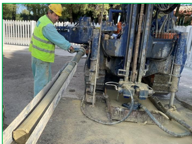
Figura 3: Esempio di estrusione meccanica del carotaggio
