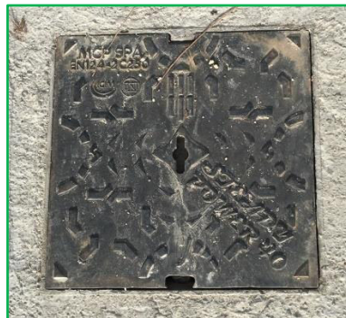
Figura 8: Protezione esterna con coperchio carrabile
