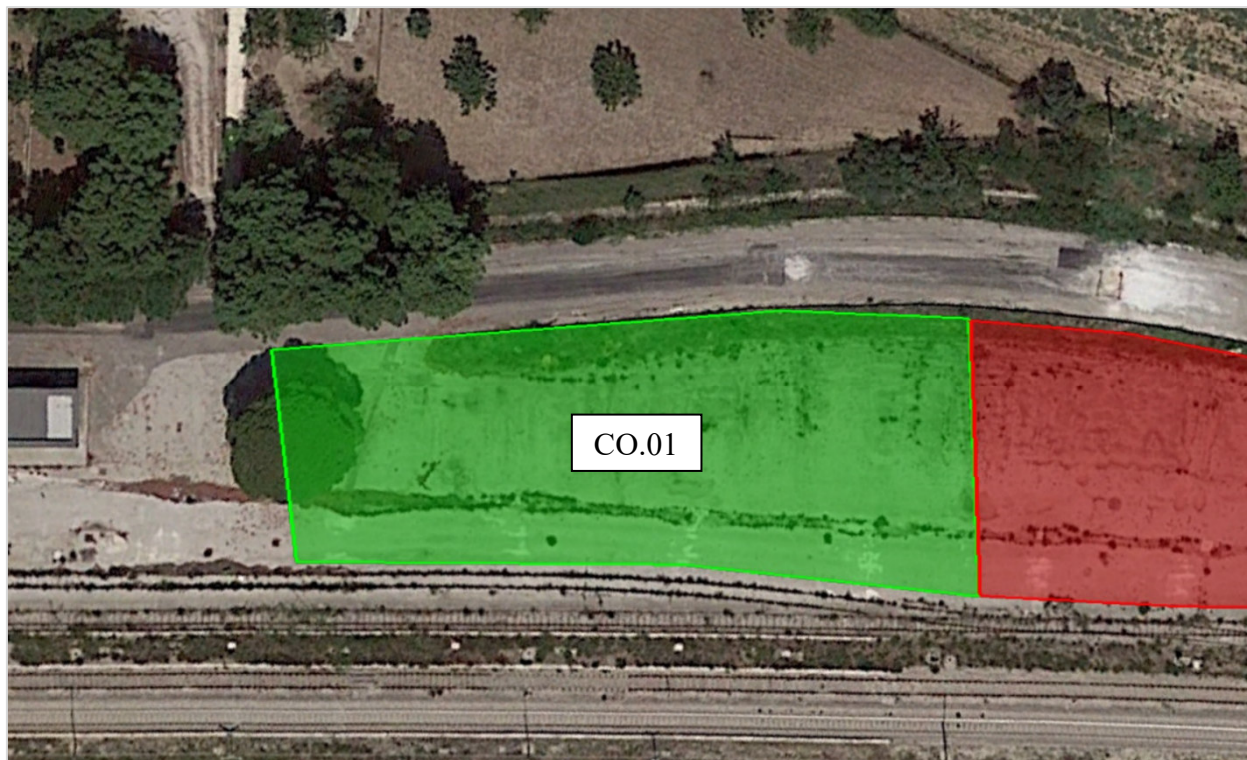
Vista aerea dell'area del cantiere operativo CO.01
