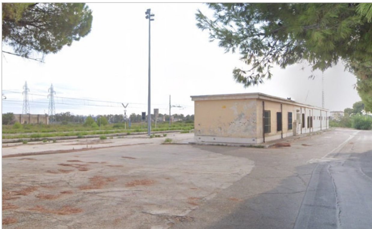
Fabbricato Viaggiatori esistente
