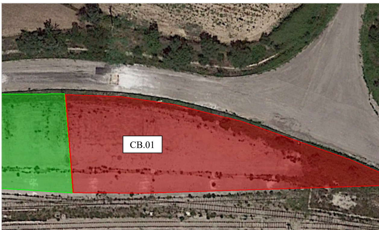
Vista aerea dell'area di cantiere C.B.01
