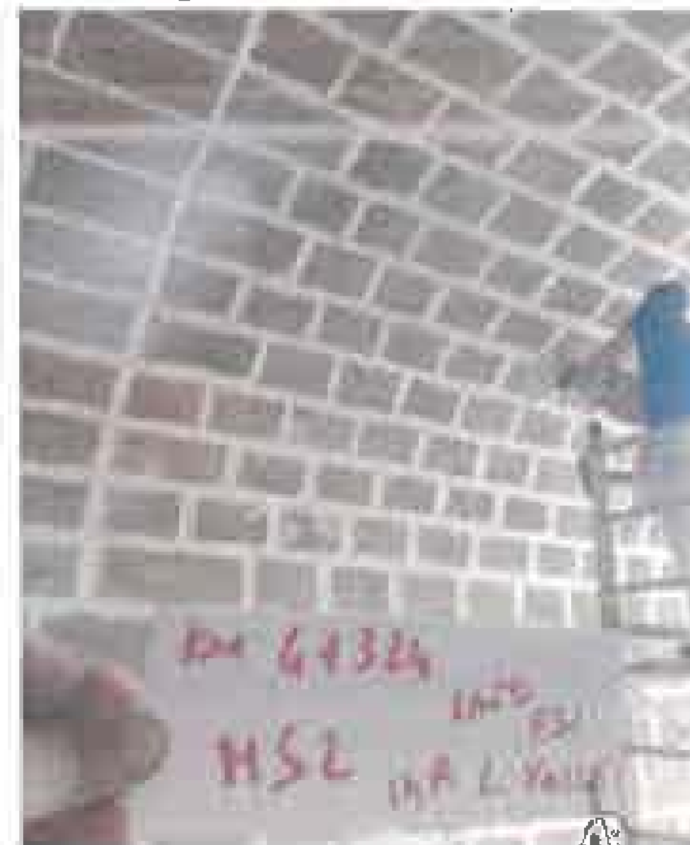
Foto 2 Taglio della muratura
