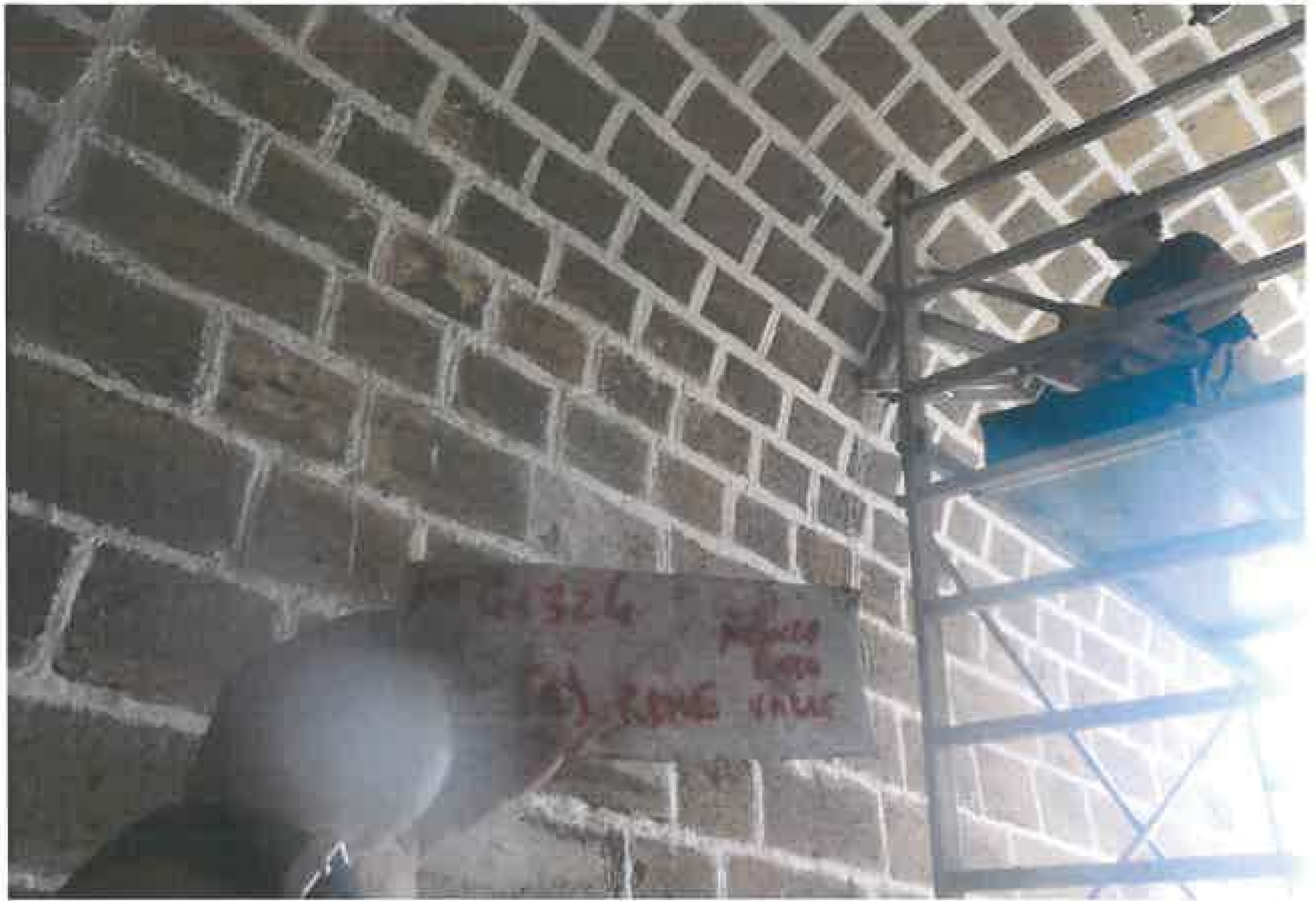
Foto 10 - Estrazione microcarota C2-v
