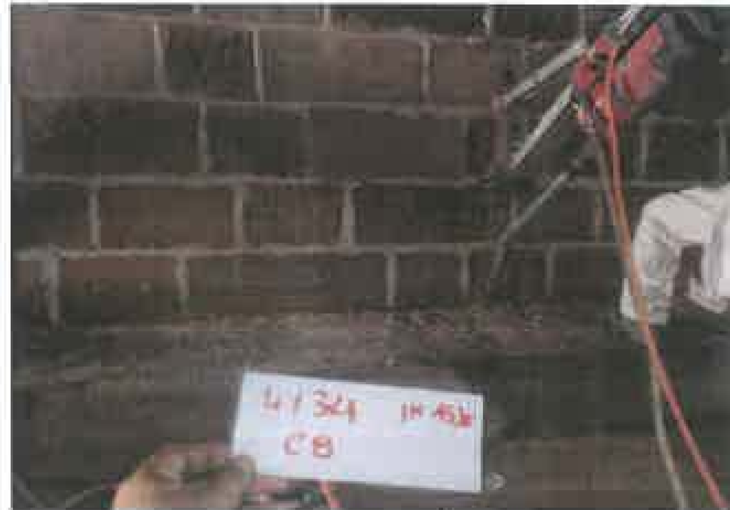
Foto n°2 - Ubicazione carota C8
