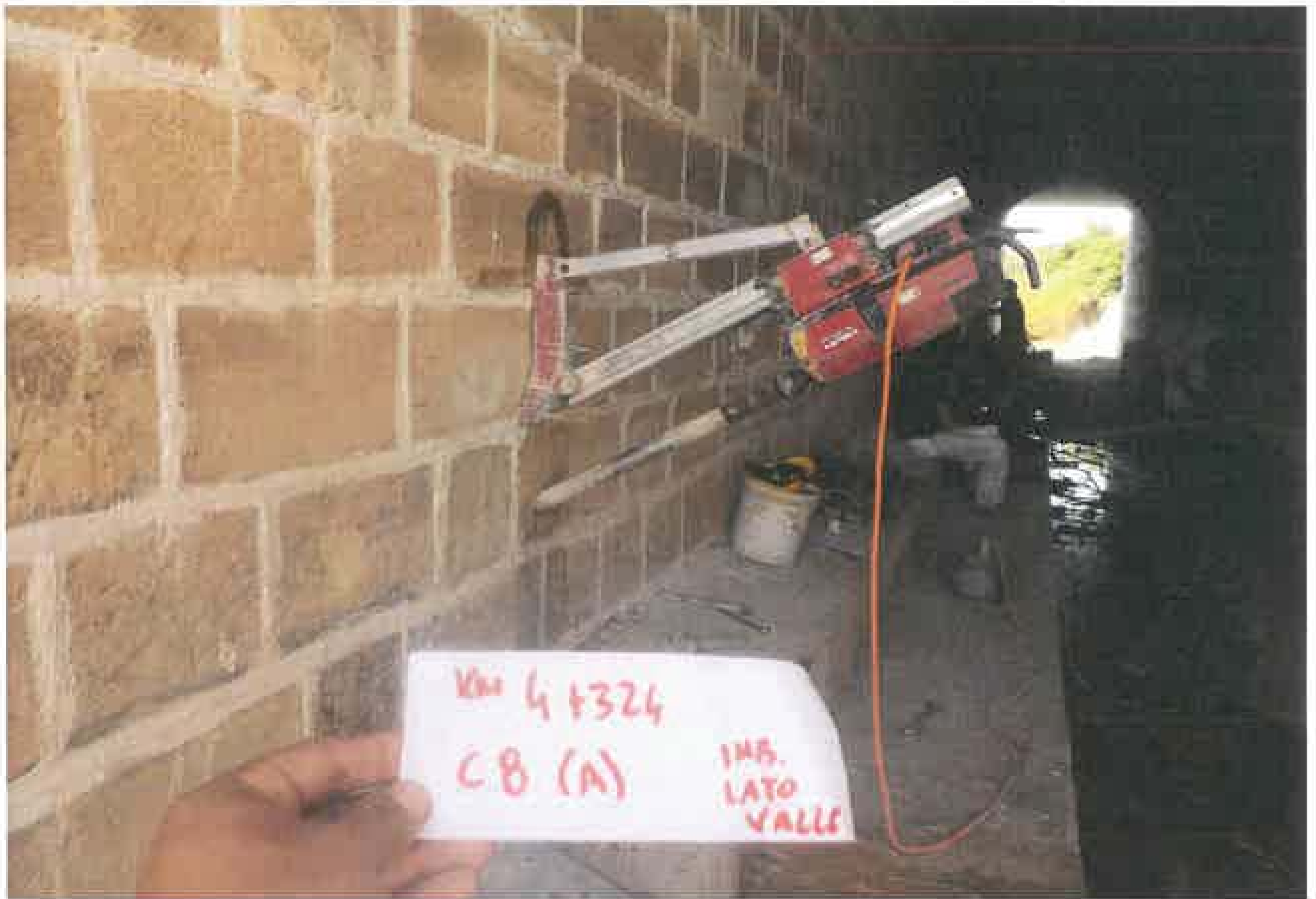
Foto 16 - Taglio inferiore della muratura MD1
