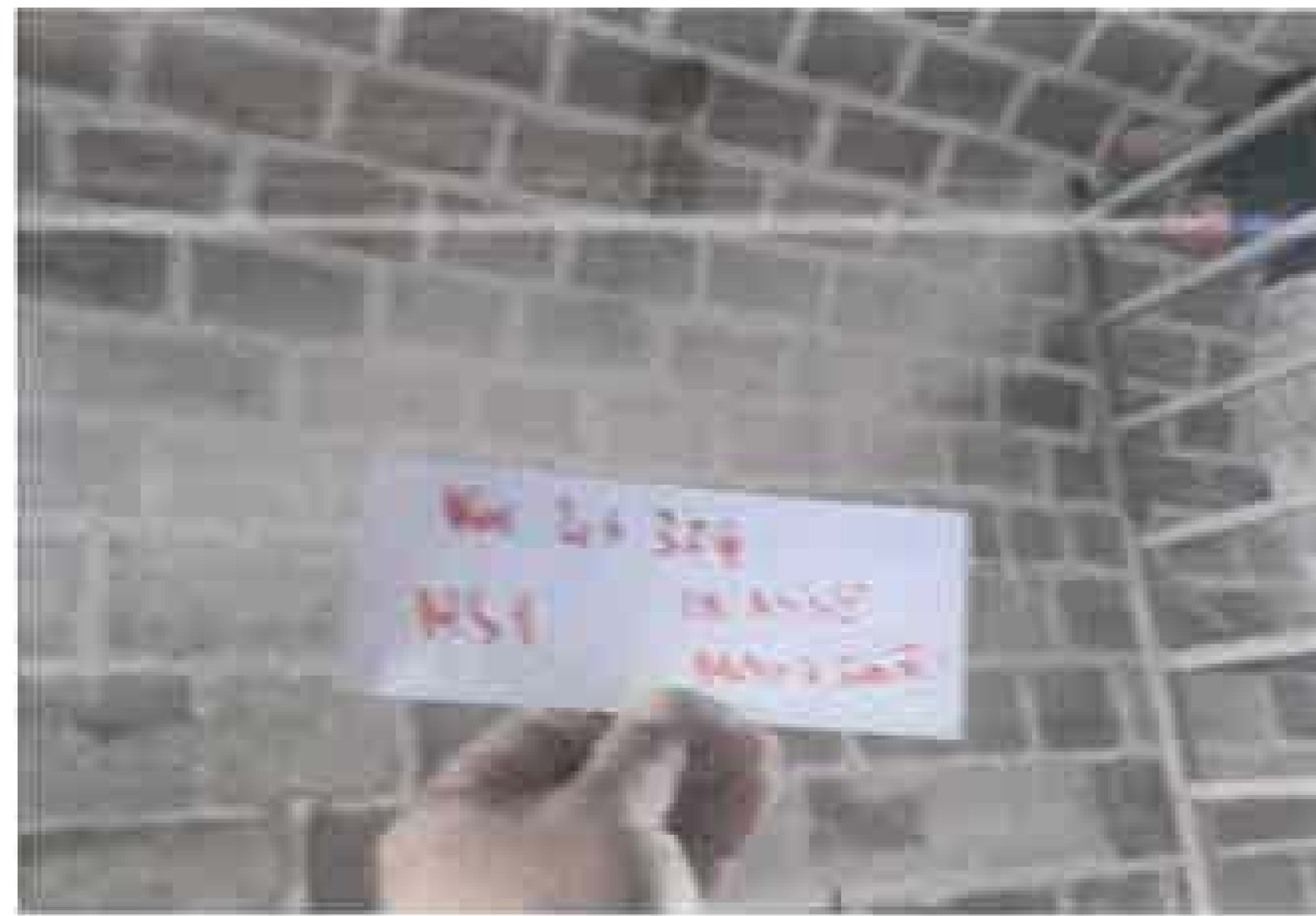
Foto 2 Fase di taglio della muratura
