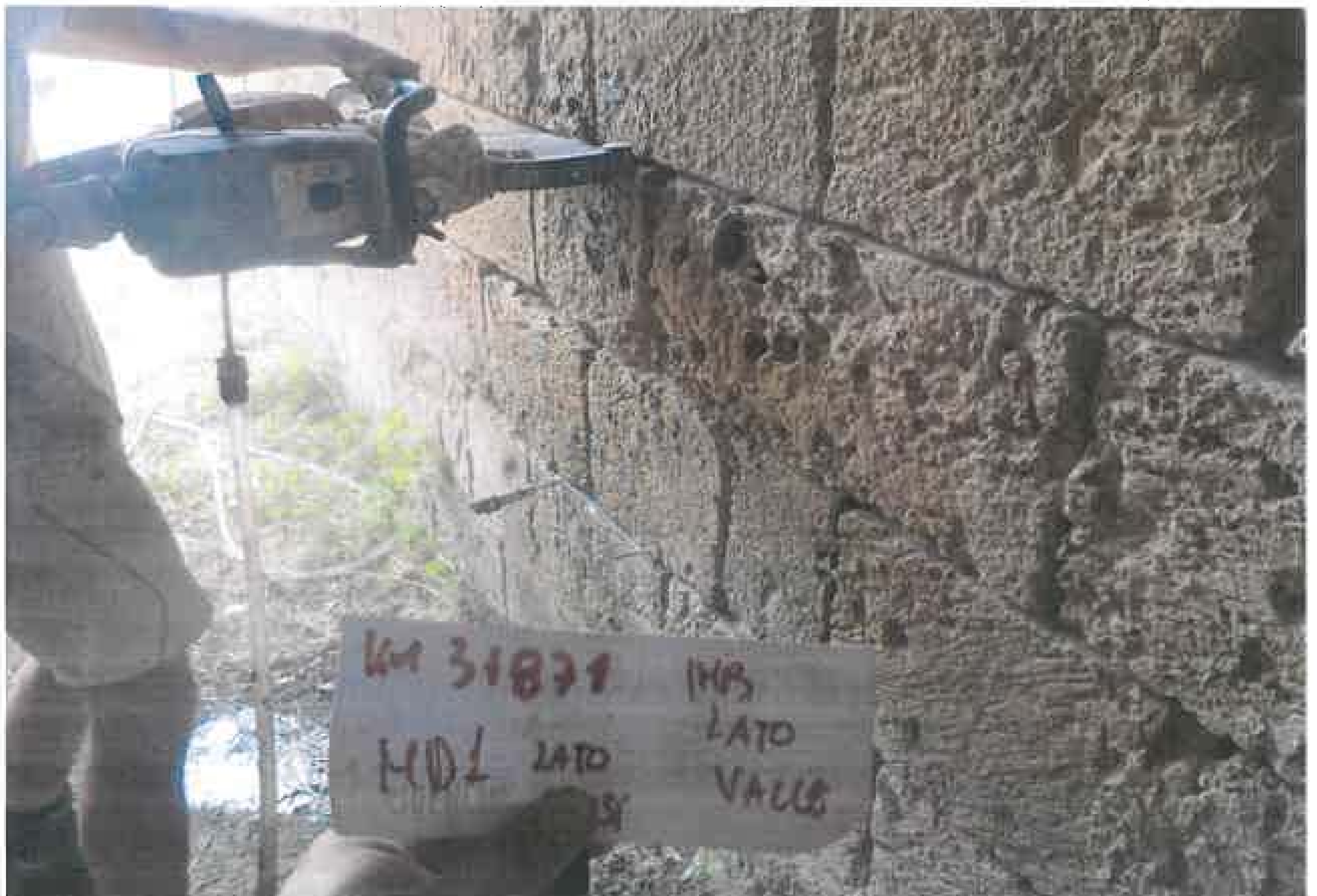
Foto 20 - Taglio superiore della muratura MPD1-v
