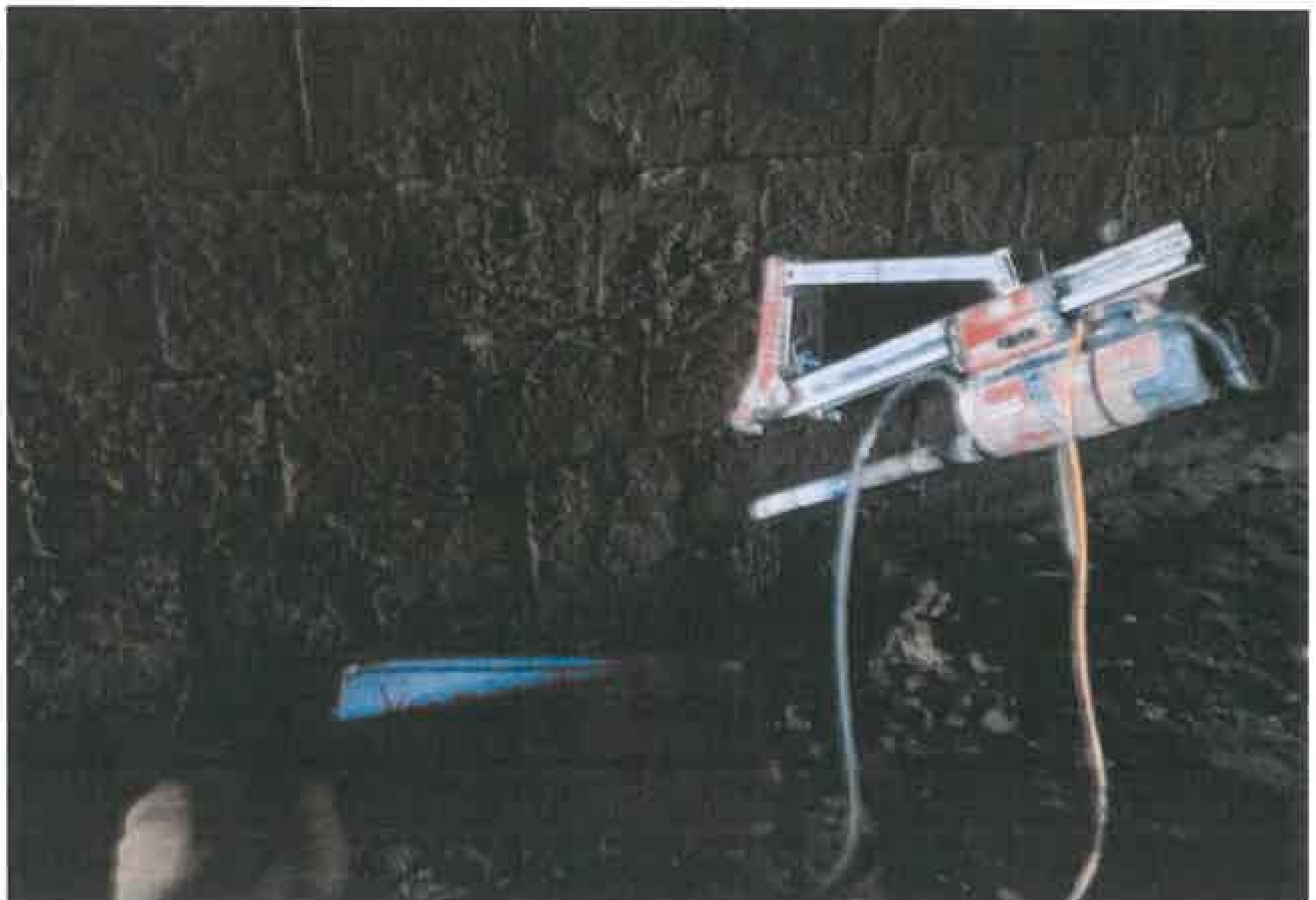
Foto 8 - Estrazione microcarota C8
