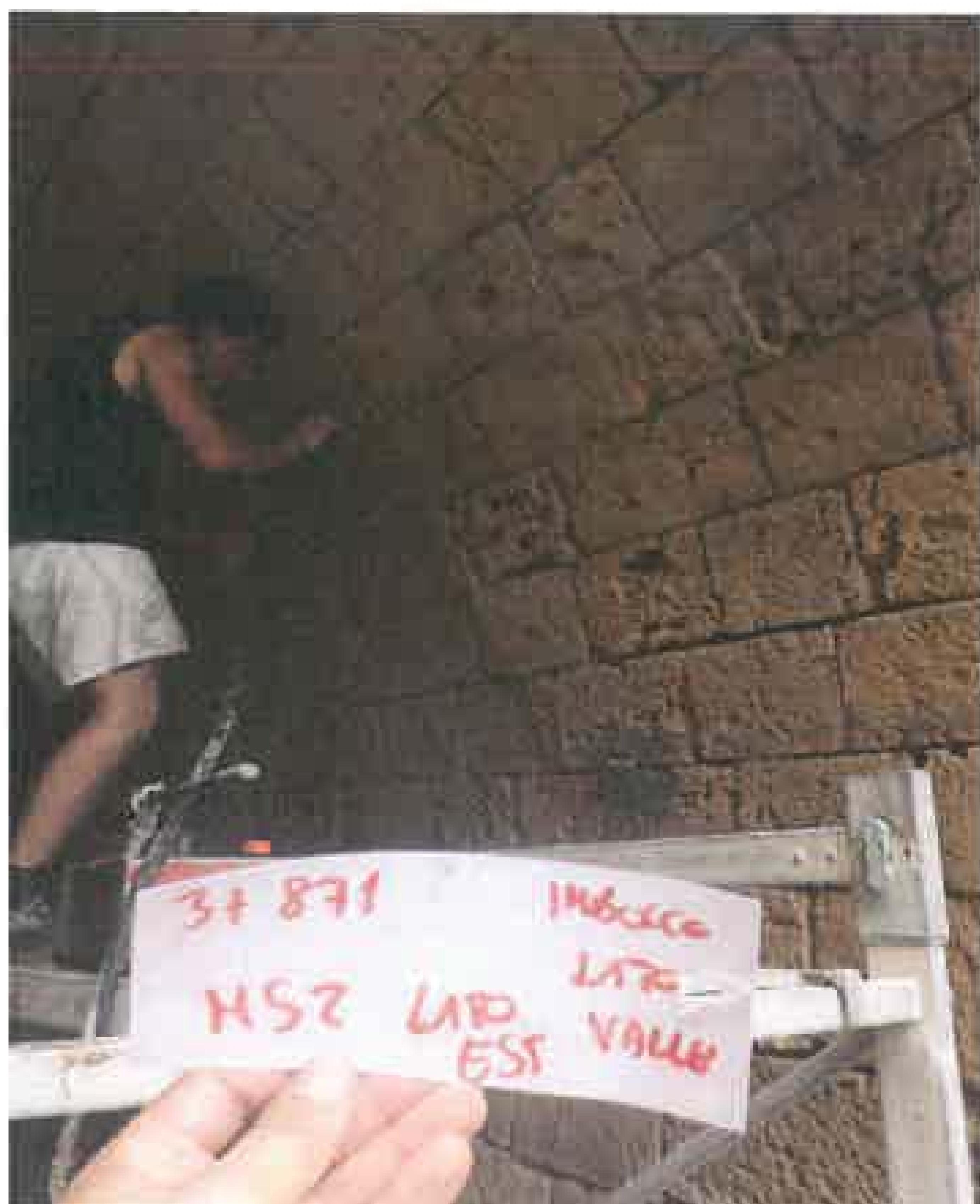
Foto 18 - Taglio inferiore della muratura MPD1
