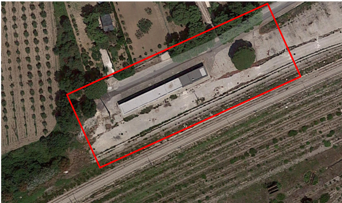
Figura 10-3 stato ante operam stazione di Nasisi quasi completamente impermeabilizzata
