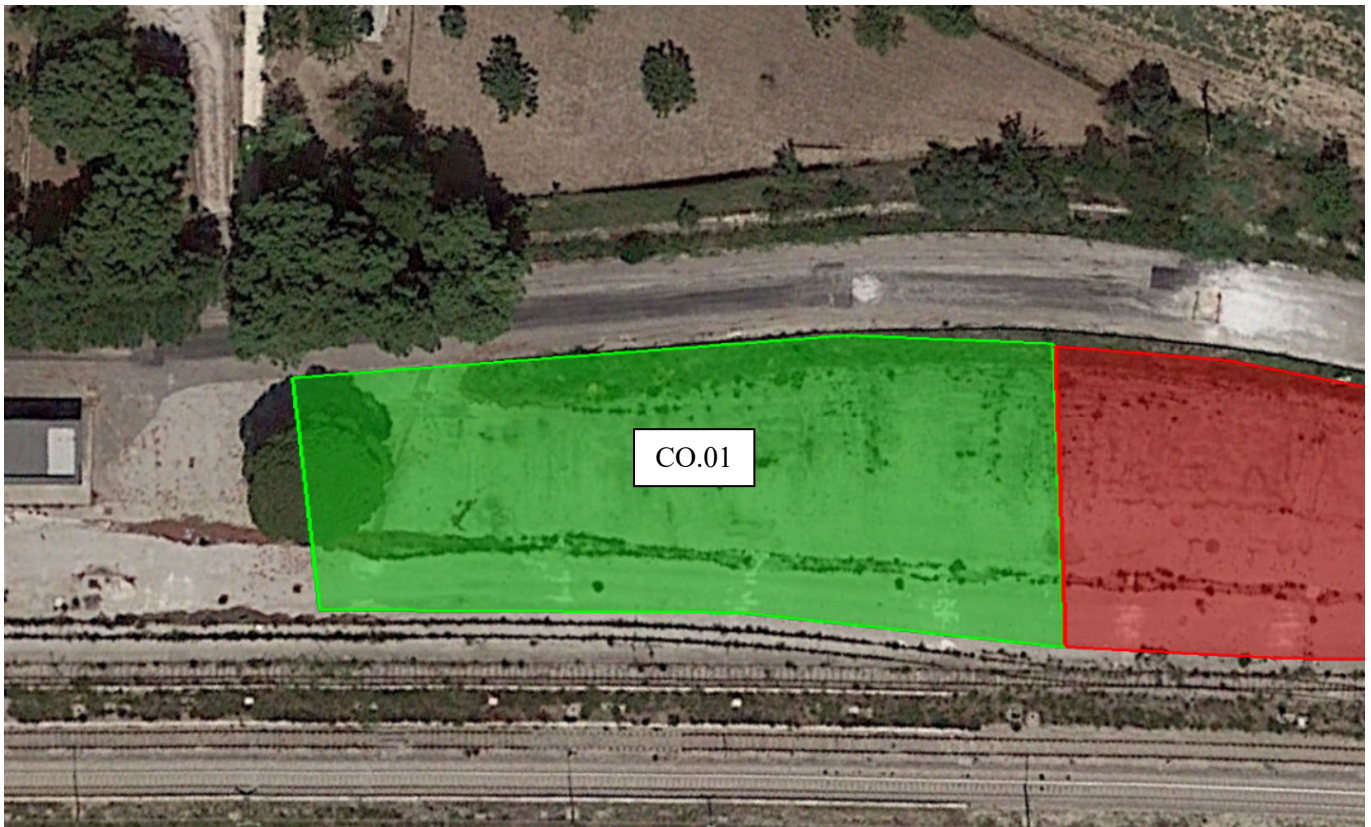
Vista aerea dell'area del cantiere operativo CO.01
