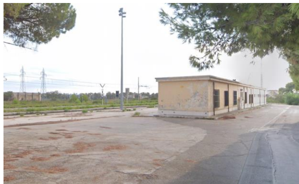
Fabbricato Viaggiatori esistente
