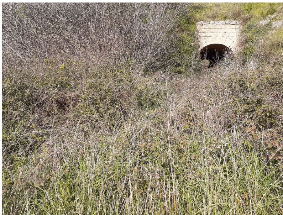
Figura 7-5 Vista dell'attraversamento IN02
