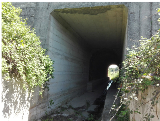
Figura 7-3 Vista di monte dell'attraversamento IN01
