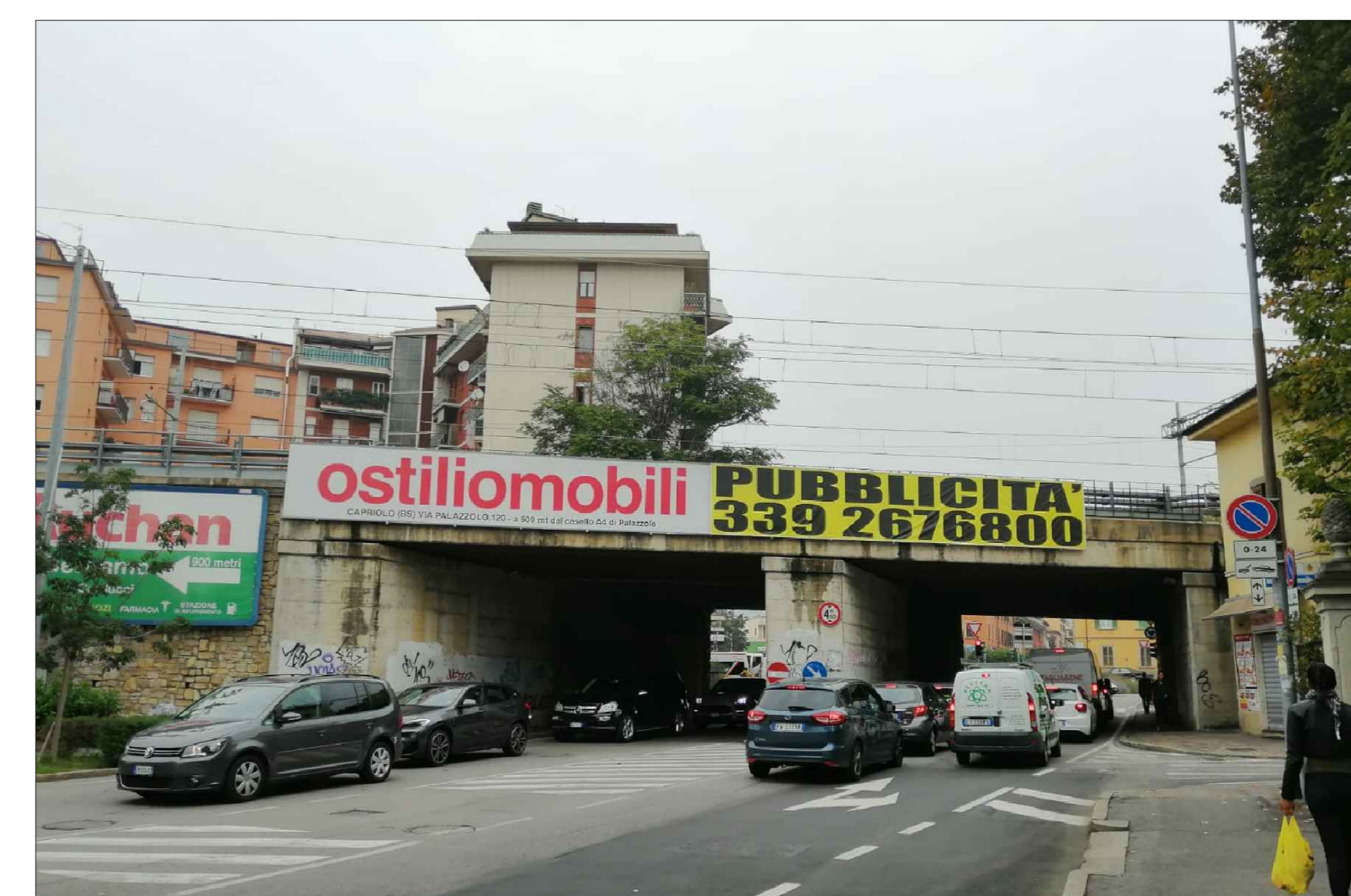
VISTA lato Sud del PONTE esistente su Via S. Bernardino
