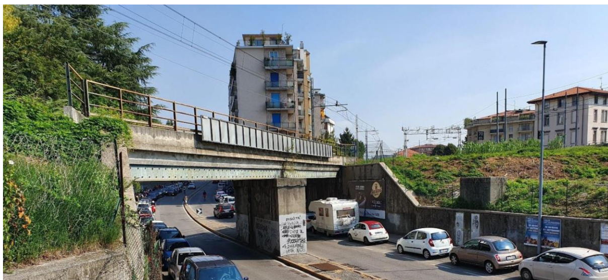
Figura 2-1 Manufatti ferroviari oggetto di demolizione: manufatti idraulici, muri di sottoscarpa e ponte ferroviario di via Caniana.
