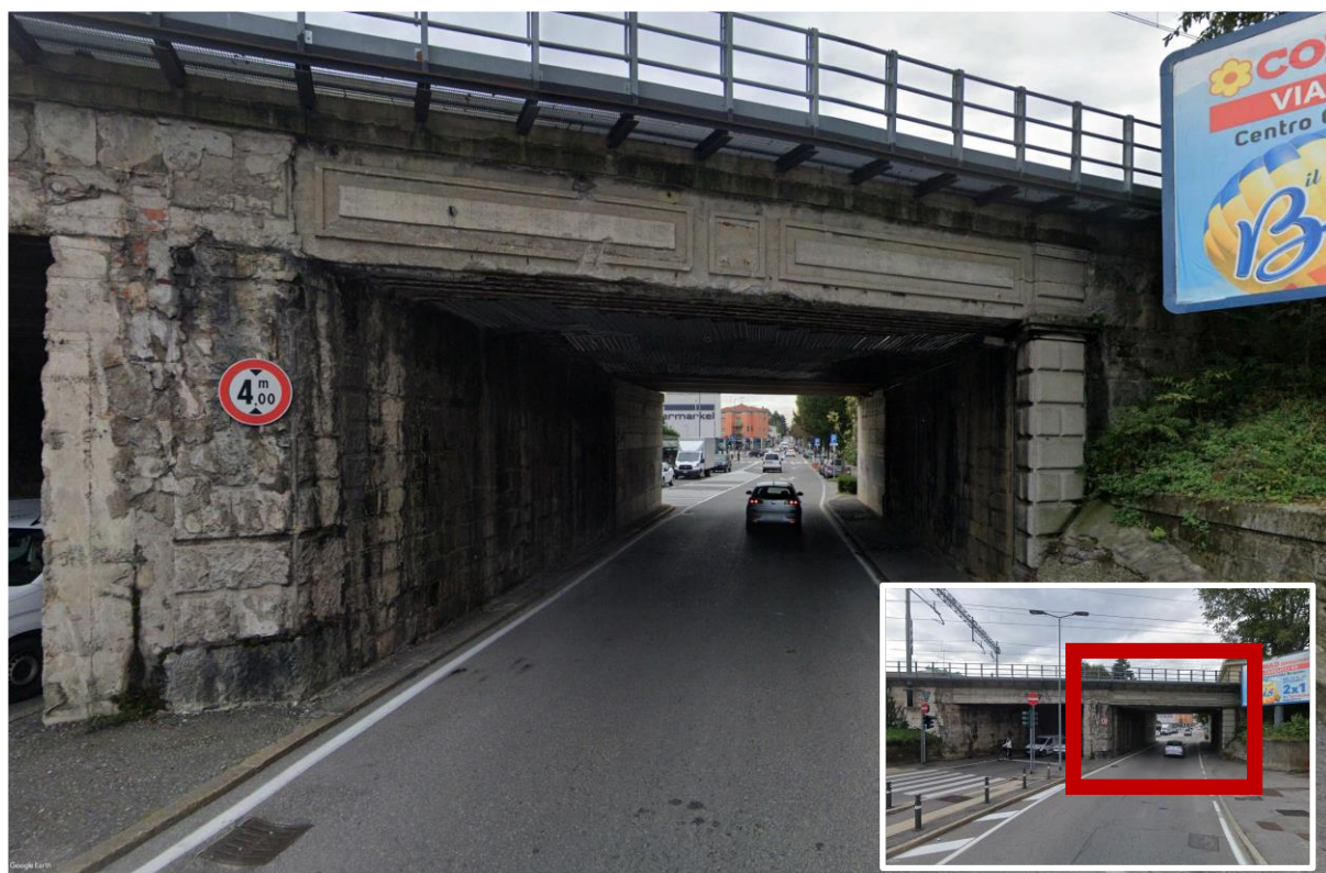
Figura 3-1 Dettagli elementi decorativi di ponte San Bernardino sulla LS da Bergamo a Ponte San Pietro.
