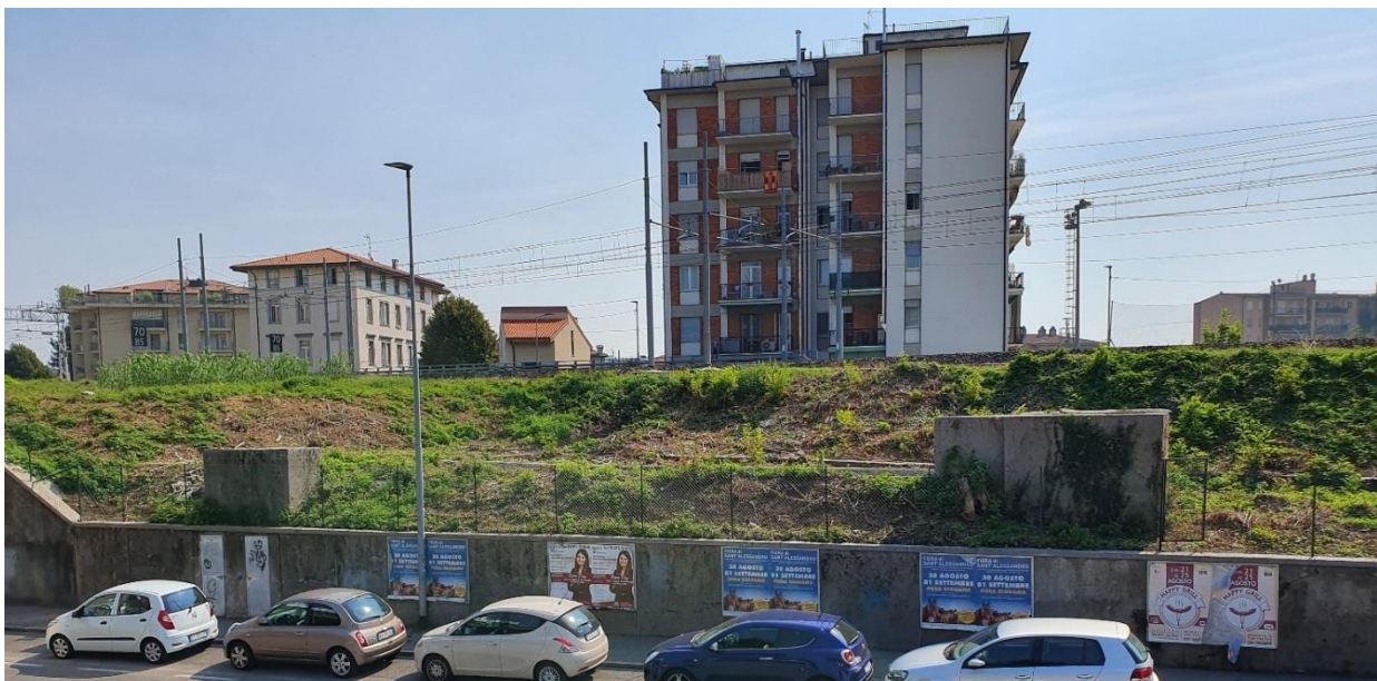
Vista dei manufatti
