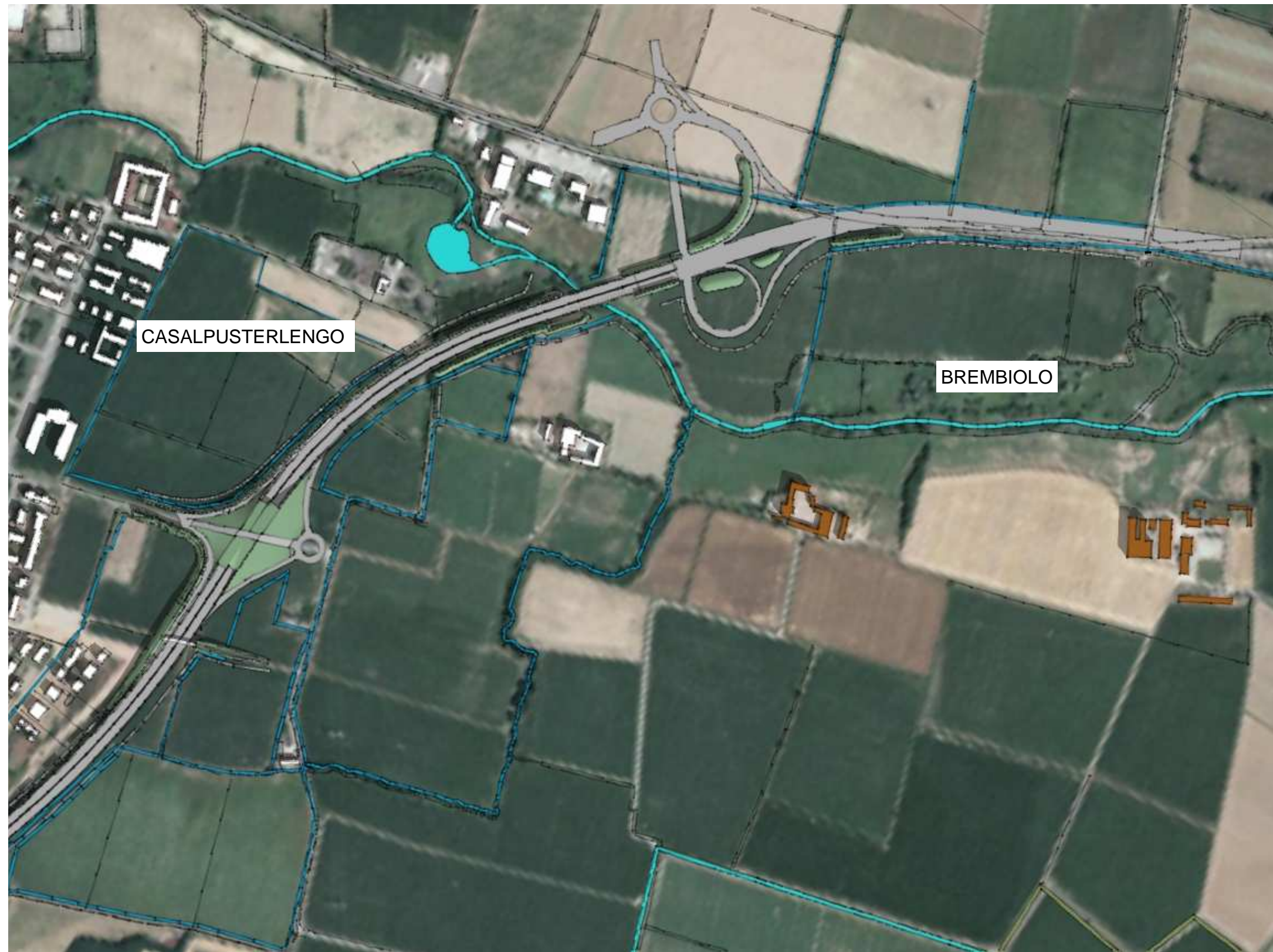
Vista zenitale – manufatto stradale
