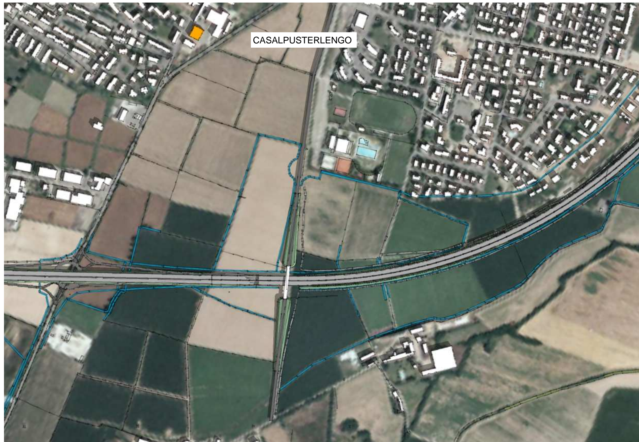
Vista zenitale – manufatto stradale
