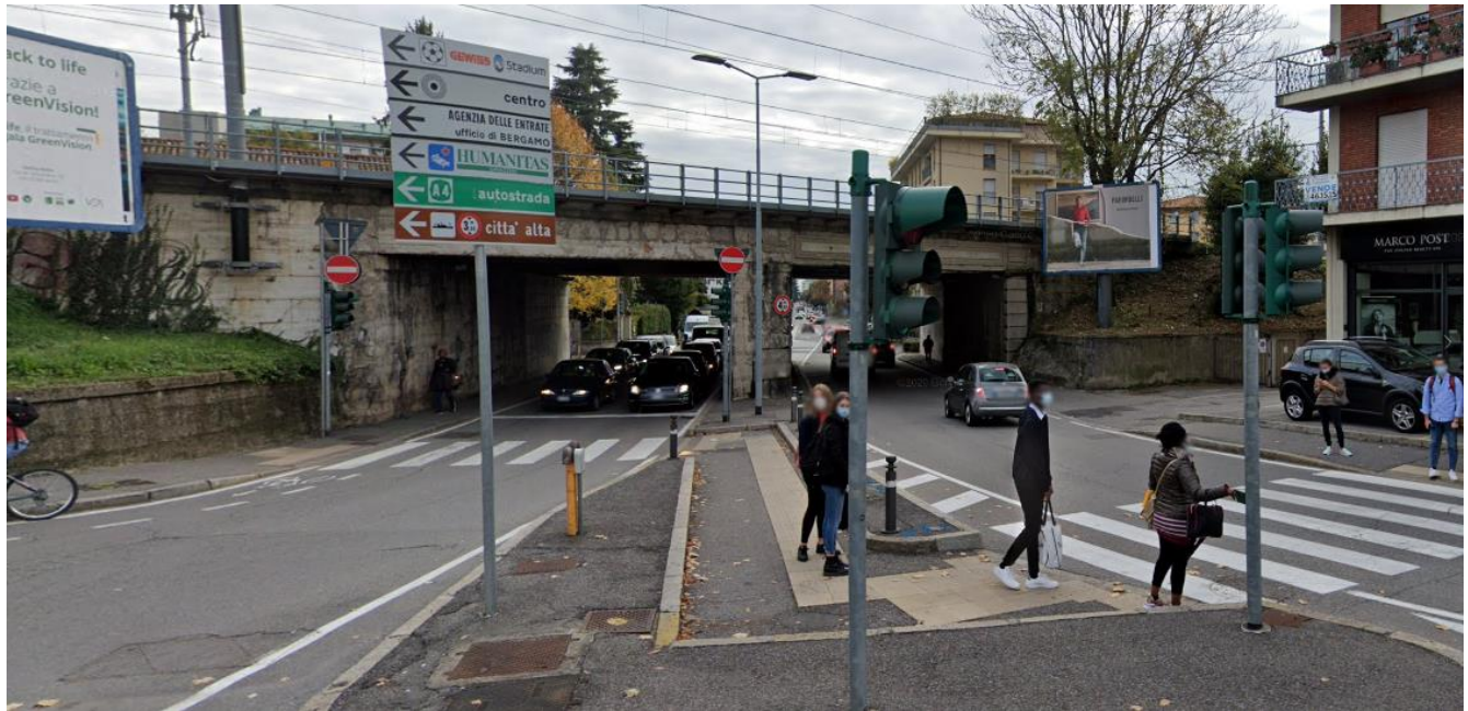
Vista del cantiere 9.AT.01A (NORD)
