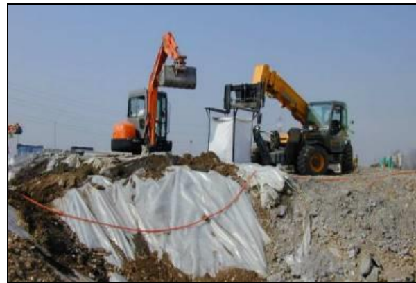
Figura 4-2 Esempio di attività eseguite sotto costante bagnatura ed utilizzo di big bags
