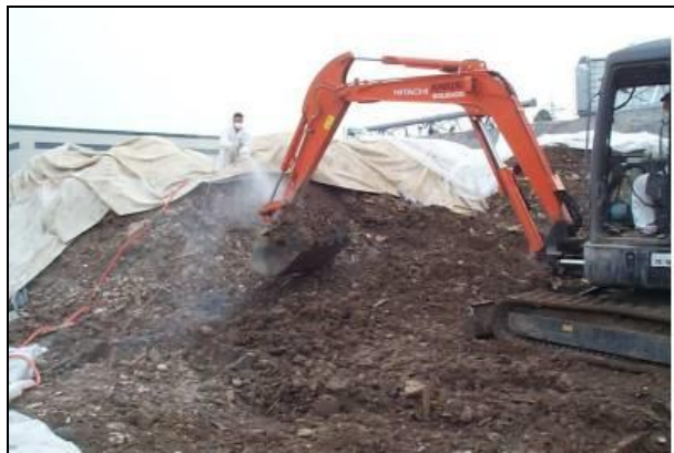
Figura 4-2 Esempio di attività eseguite sotto costante bagnatura ed utilizzo di big bags
