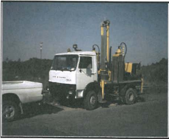
Piazzamento prova n. 1
