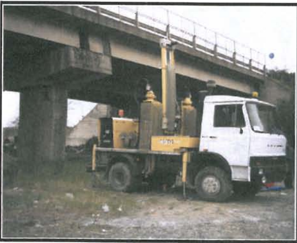
Piazzamento prova n. 3
