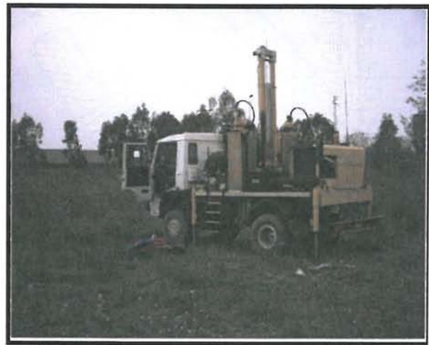
Piazzamento prova n. 2
