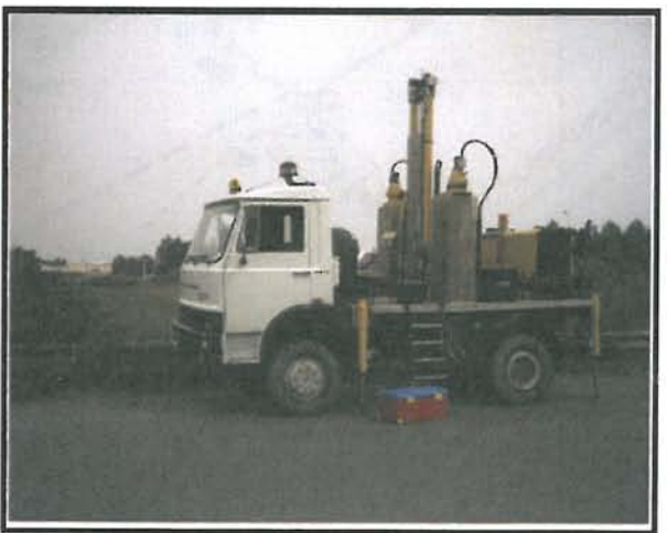
Piazzamento prova n. 4
