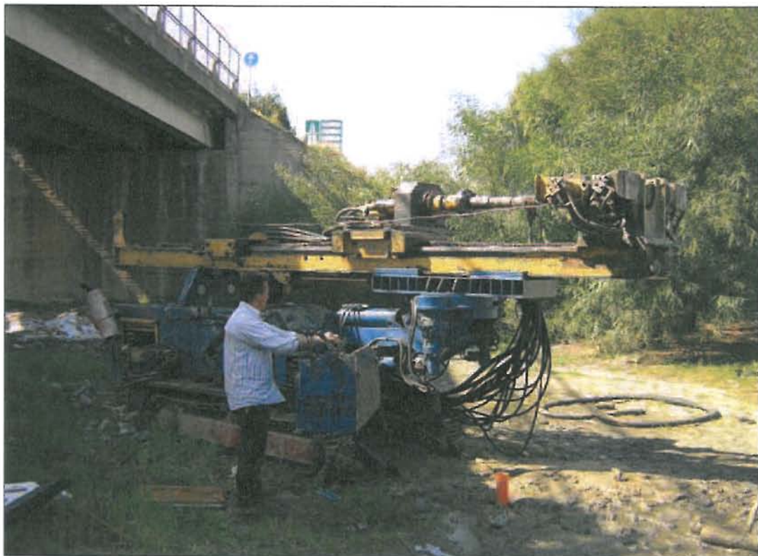
Foto 17 – Piazzamento sondaggio S5
