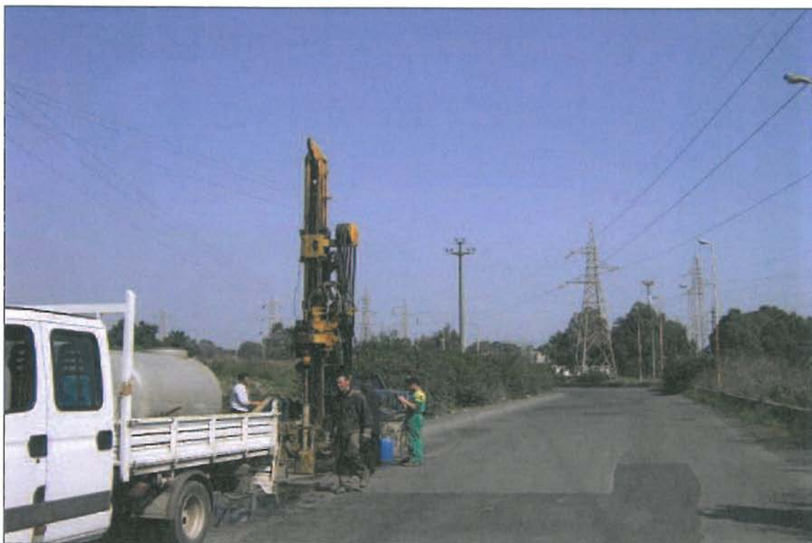
Foto 13 – Piazzamento sondaggio S4
