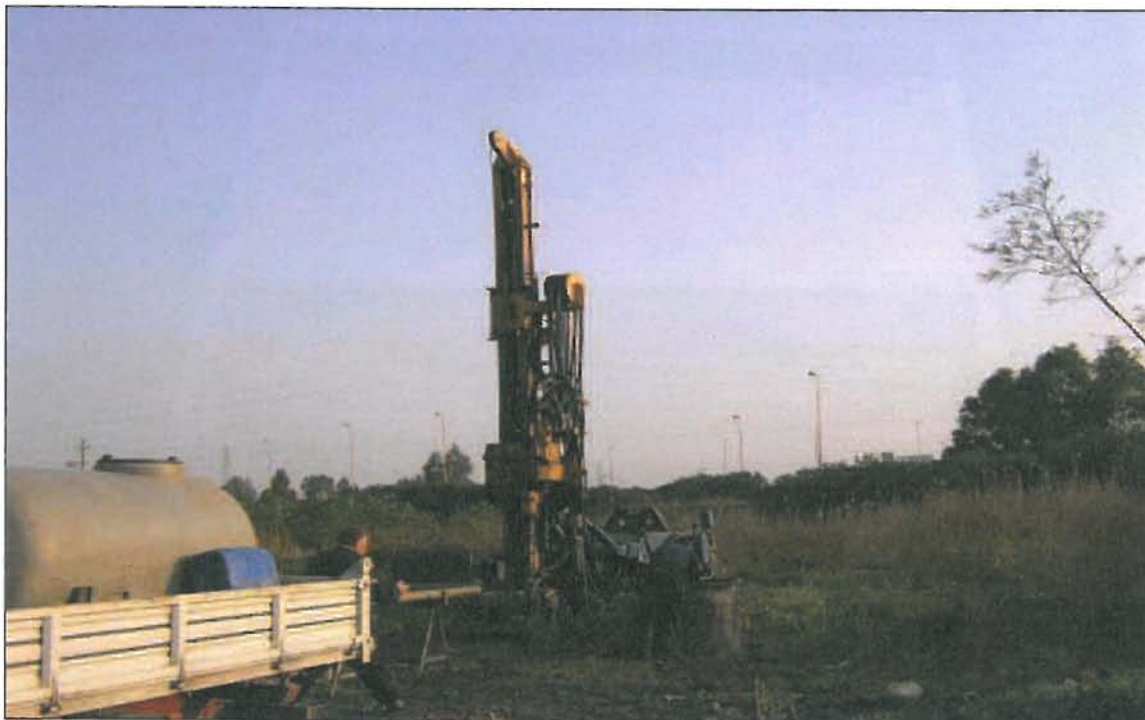
Foto 9 – Piazzamento sondaggio S2
