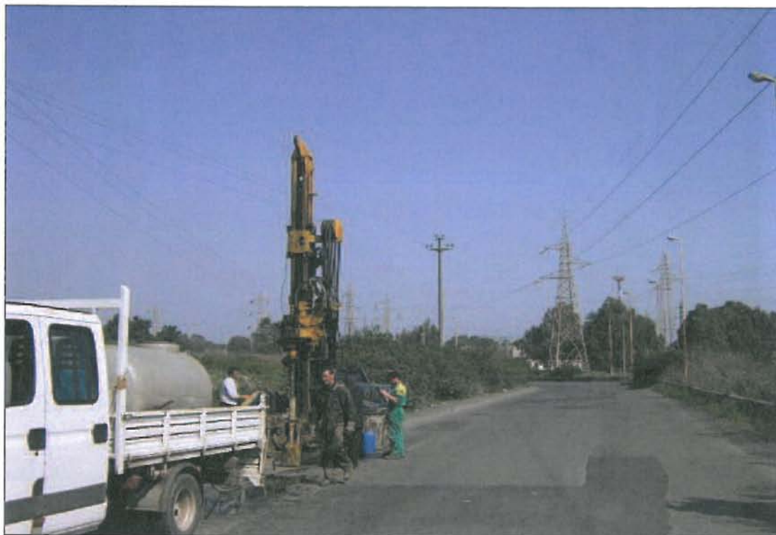
Foto 5 – Piazzamento sondaggio S2
