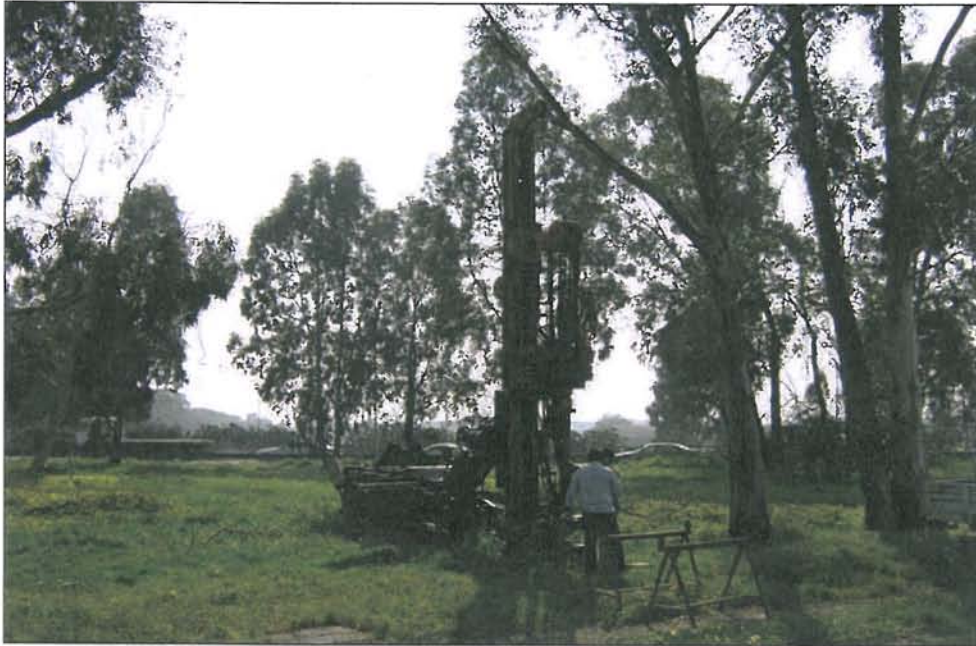
Foto 1 – Piazzamento sondaggio S1
