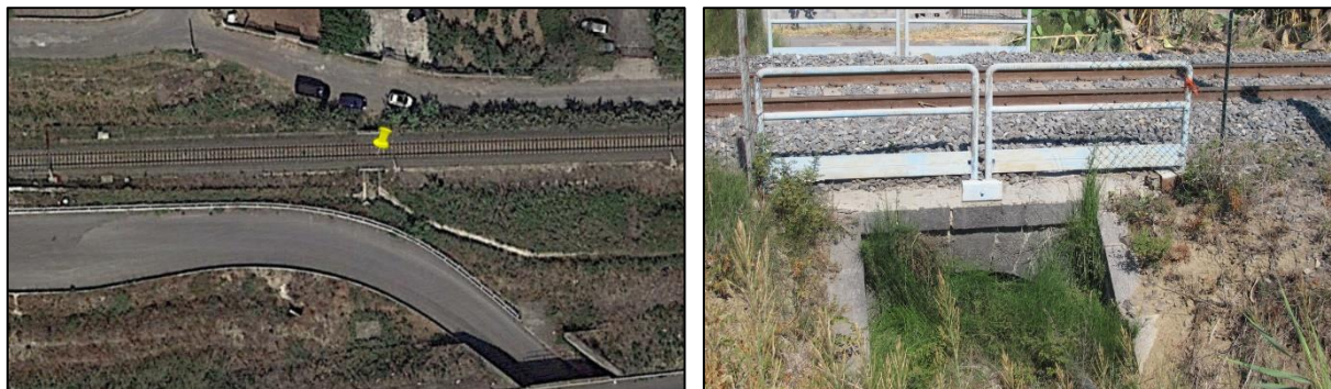
Figura 3 - Stato di fatto
