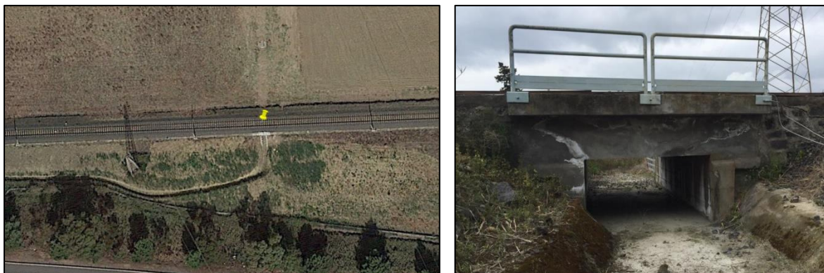
Figura 5 - Stato di fatto
