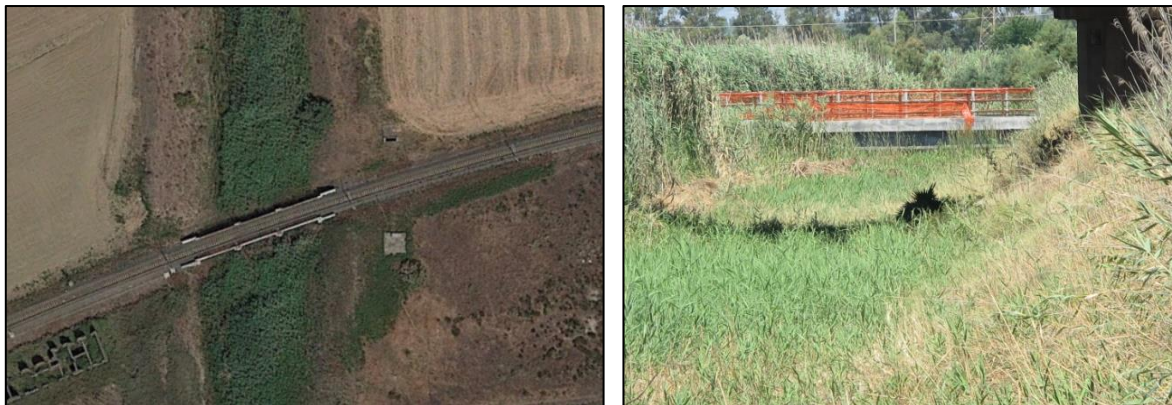
Figura 7 - Stato di fatto
