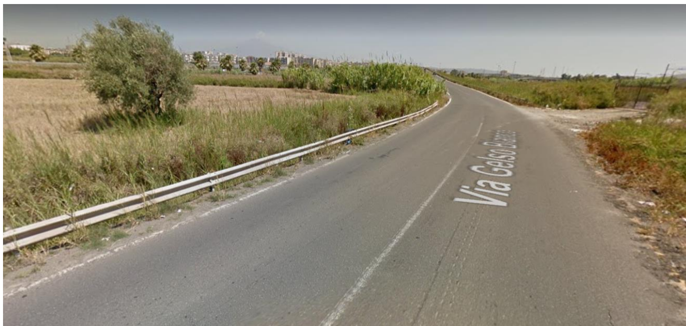
Figura 1: Vista della SP 55 esistente
