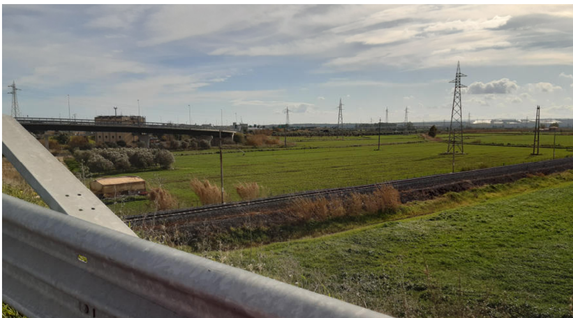
Vista dell'area DT.03 dal cavalcavia di SC Passo Cavaliere
