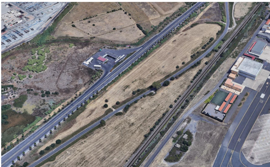
Vista aerea dell'area CB.01
