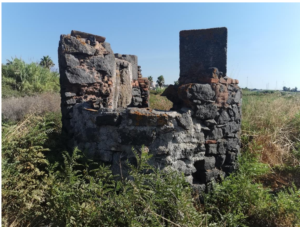
Fig. 18 – Struttura di forma cilindrica con muratura in blocchi di pietra lavica e laterizi presente nell'area dell'UR 60..
