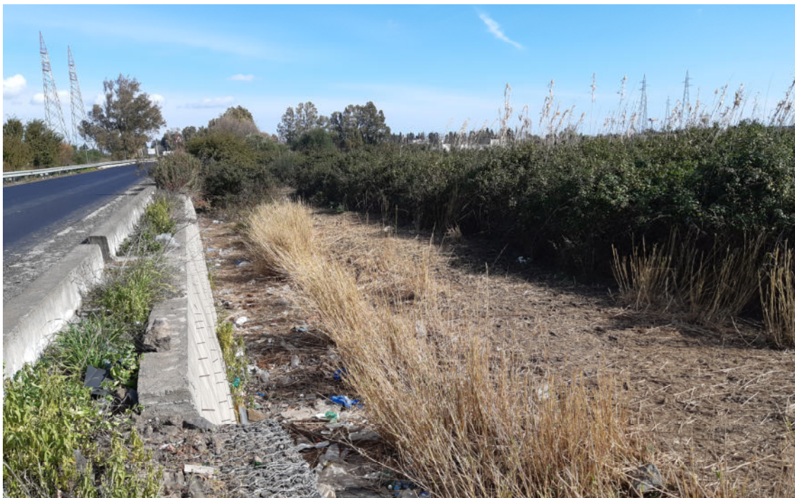
Vista del canale tra il piano stradale e l'area CB.01
