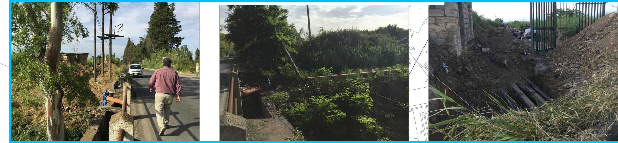
ATTRAVERSAMENTO CONDOTTA IDRICA ACQUE SUD
