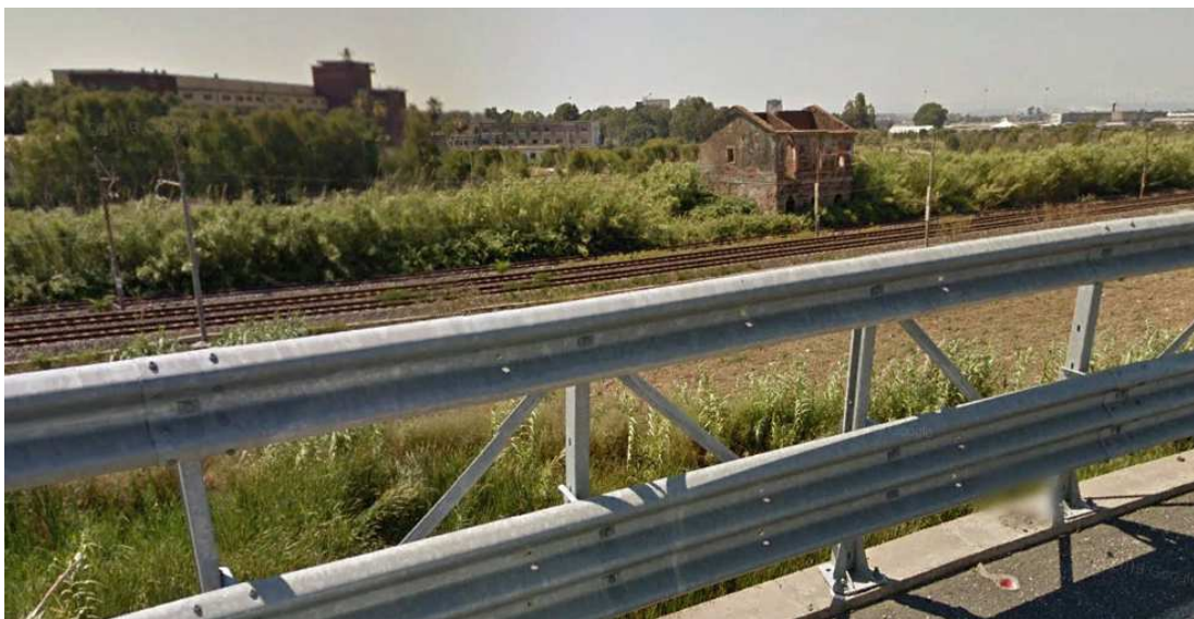
Figura 5-6- Foto del tratto di binari esistenti su cui sono previsti gli interventi del Lotto 1 che ricade in aree soggette a vincolo (fascia dei 150 metri dei fiumi – art. 142, let. "c" del D.Lgs 42/2004).
