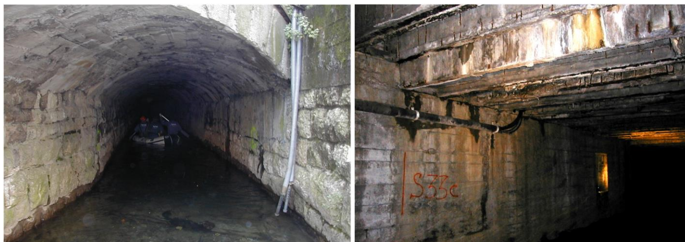
Figura 4 – Canale Adigetto (tratto tombato)
