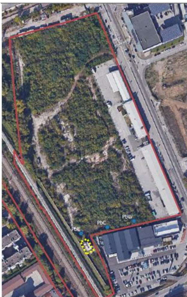
Figura 8 – Ubicazione barriera idraulica e impianto di trattamento acque
