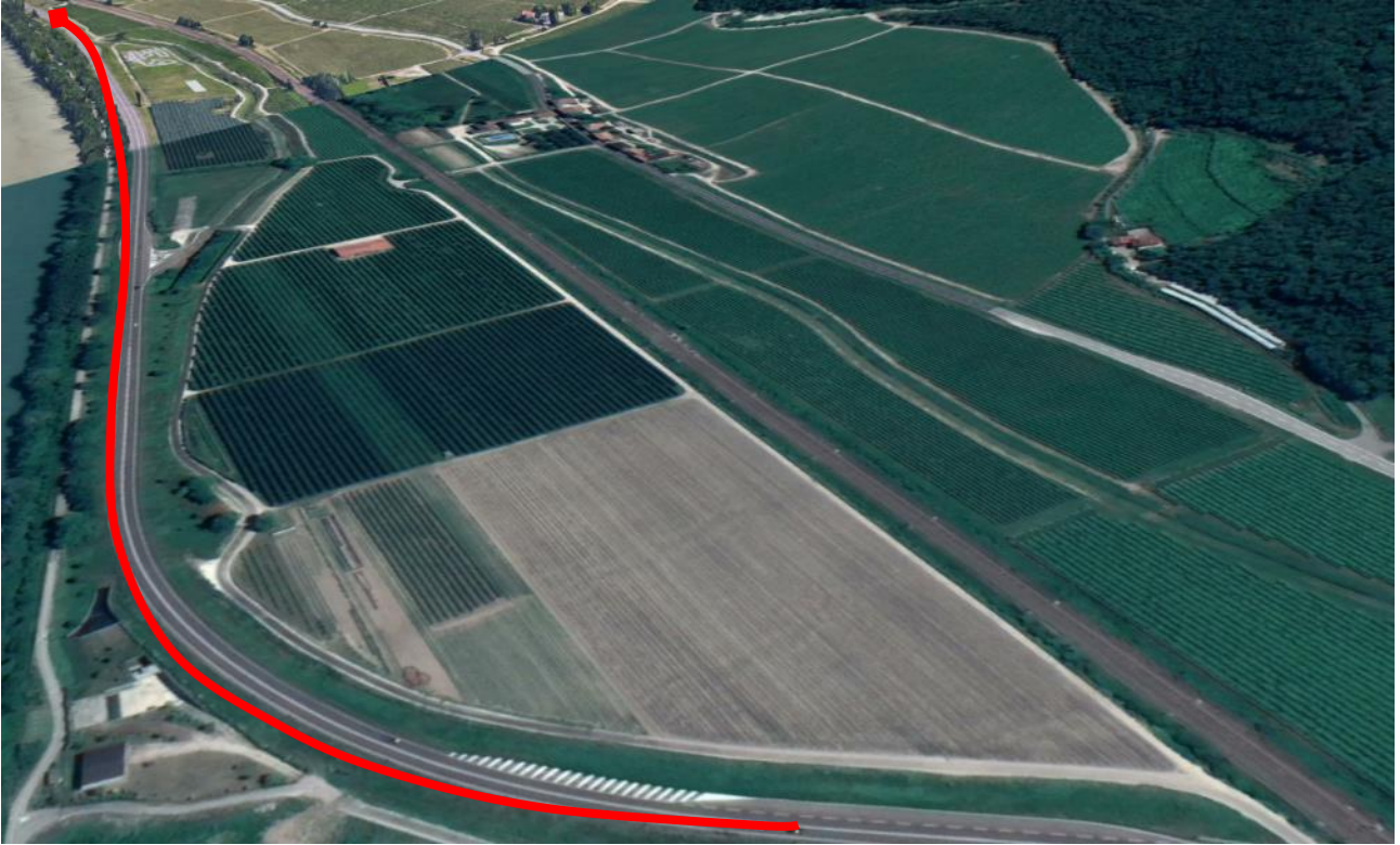
Figura 5-19 Vista dell'area destinata ad ospitare l'area di stoccaggio AS.04. In rosso la SS12, da cui sarà visibile l'area di cantiere.
