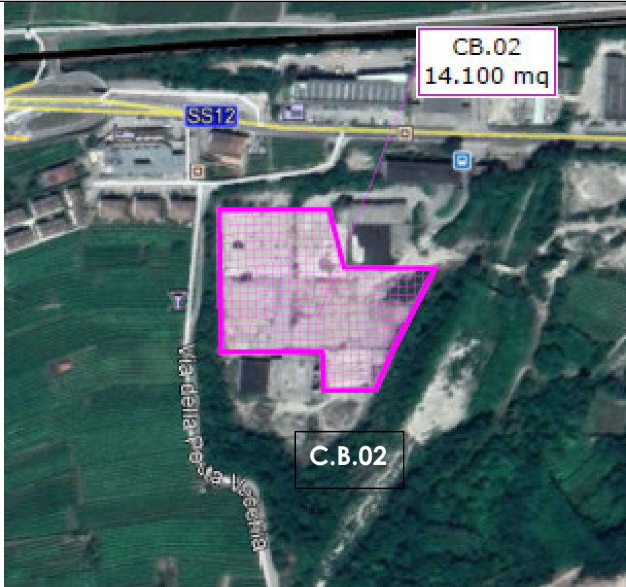
Vista aerea del CB.02
