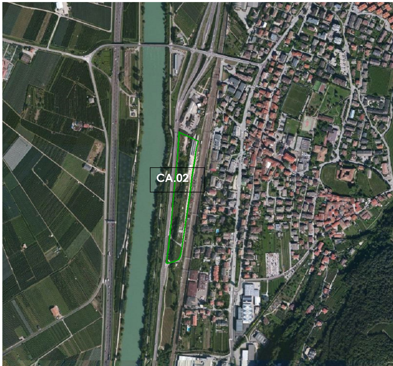
Vista aerea della CA.02
