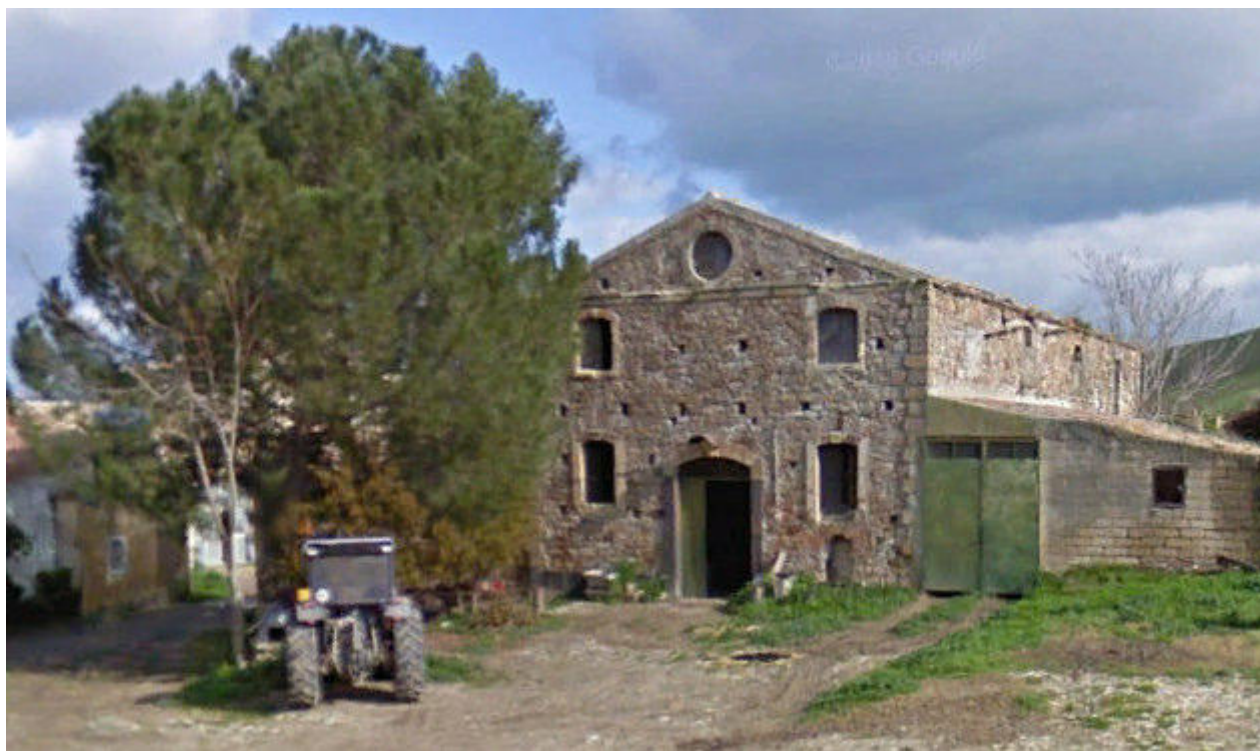
Vista porzione frontale
