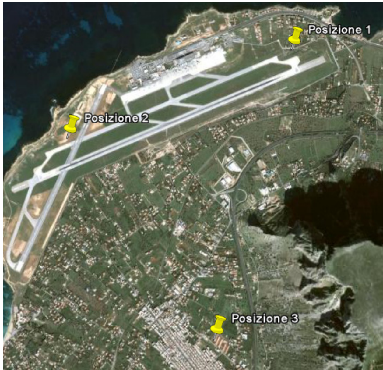
Figura -12 Siti di posizionamento del laboratorio mobile della Provincia di Palermo
