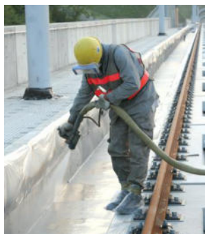
Figura 12.8.4.2.6.a - Applicazione a spruzzo della membrana impermeabile
