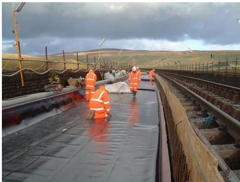
Figura 12.8.4.2.2 - Lavorazione con il 2° binario in affianco sostenuto
