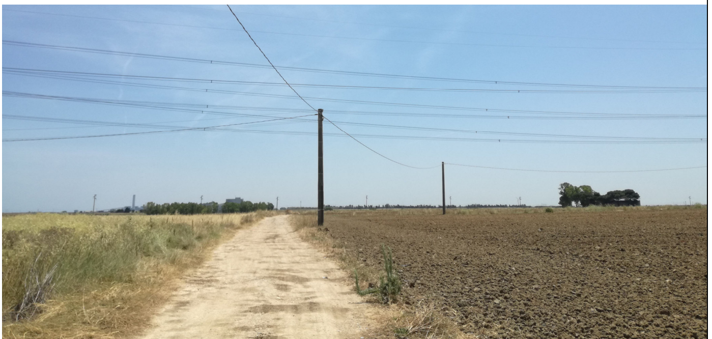
Foto 1 – Strada poderale da adeguare
