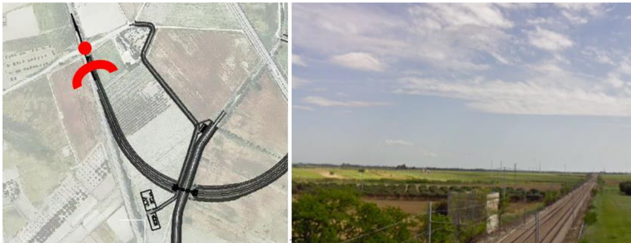
Figura 5-20 Opera di linea alla pk 4+854 rilievo fotografico
