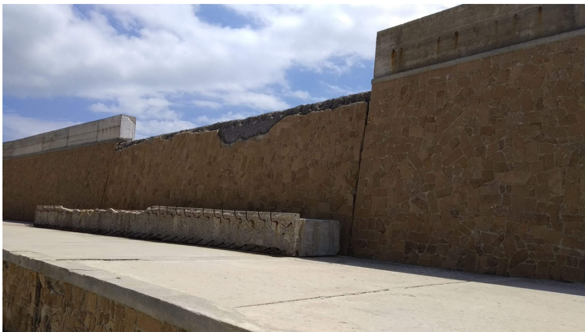
Vista muro paraonde ante operam
