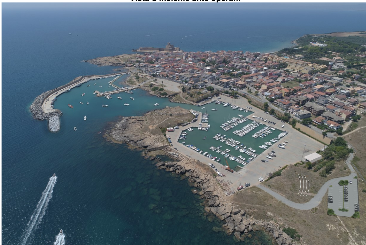
Vista d'insieme post operam
