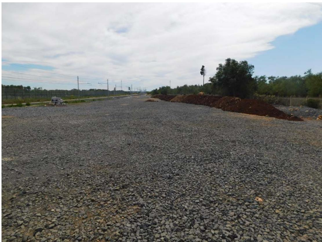
Figura 3-70 Area del rilievo coperto da uno strato spianato di pietrisco ferroviario (ballast)
