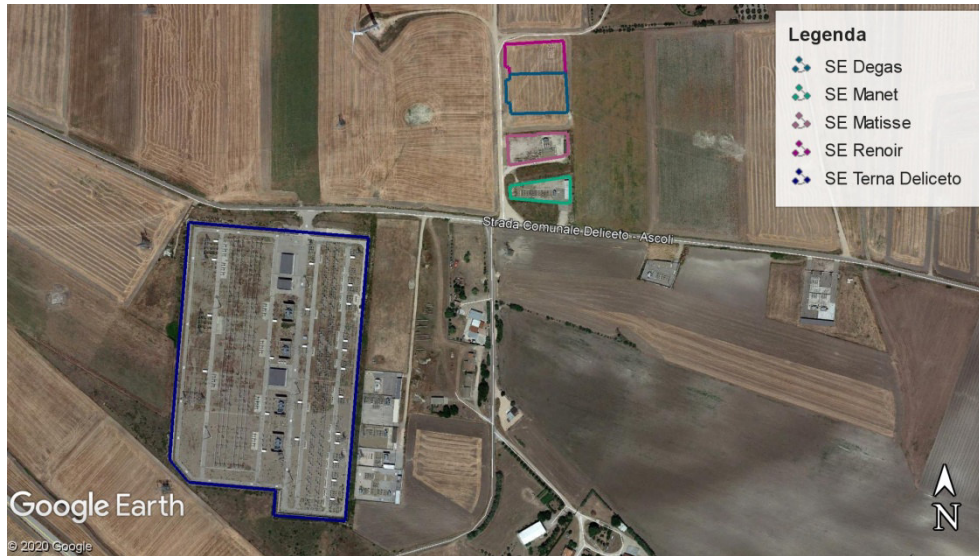
Ubicazione area sottostazione "Degas"
