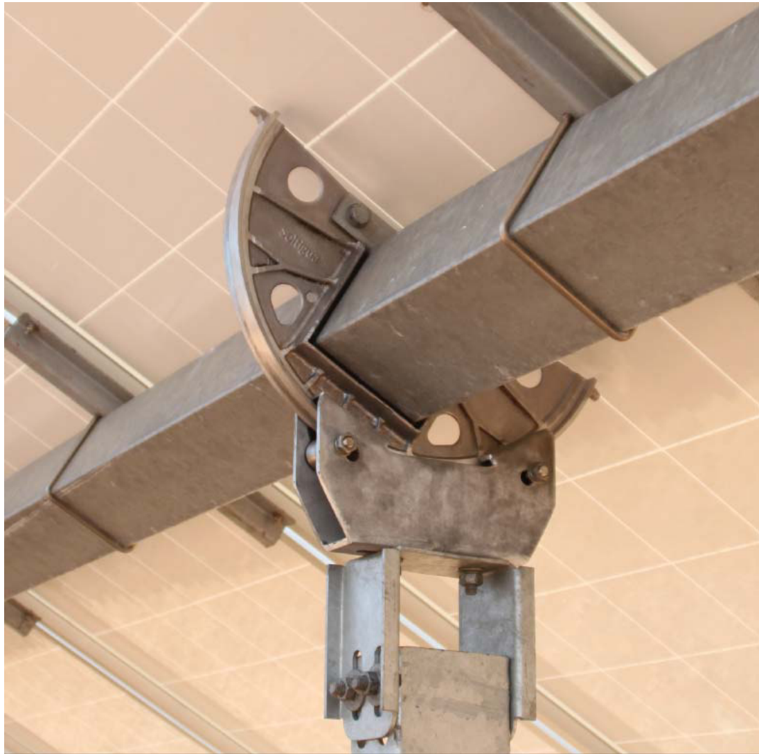
FIGURA 6: SCHEMA NODO TRAVE CONTINUA / COLONNA
