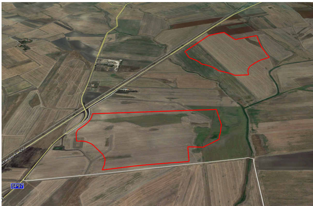
impianto fotovoltaico (aree pannellate)
