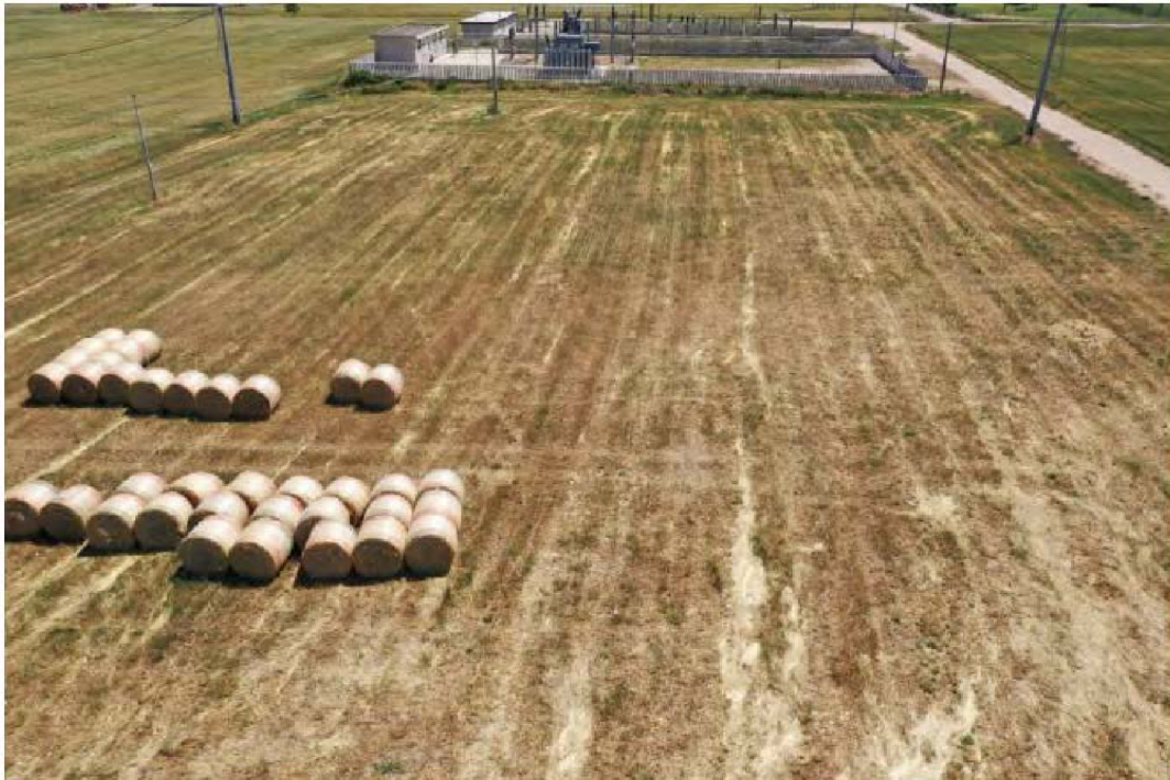
Figura 6. Comune di Deliceto. Area della Sottostazione Elettrica vista da N.
